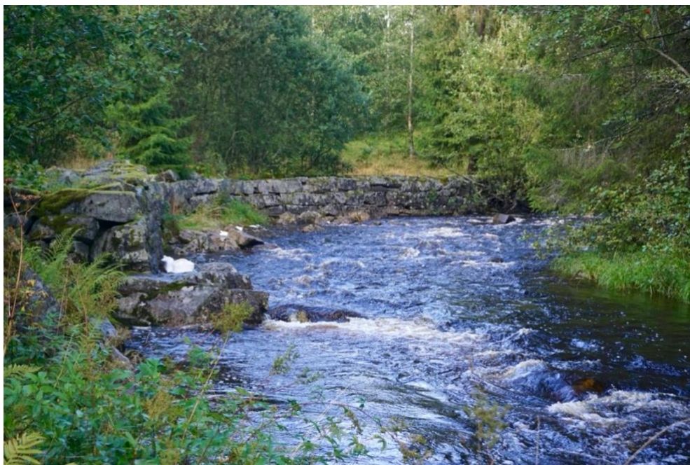
I følge Lars Åmot finnes skådammer langs store deler av Henåa. De tilhuggede steinene er av den lett formbare bergarten amfibolitt, som er vanlig i disse trakter.
