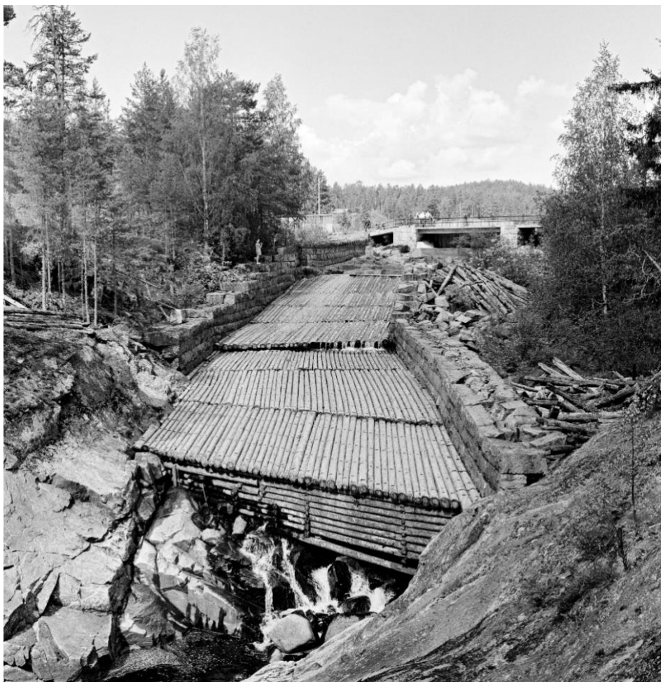
Illustrasjonsbilde av såkalt «flakning» ved Haldammen i Glommavassdraget. Flakningen går fra dammen over et ujevnt parti og avsluttes på en tømmerkiste. Foto: Anno Norsk Skogmuseum
