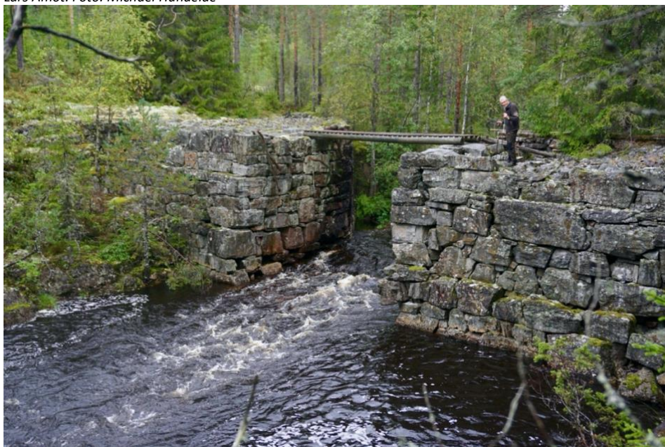
Ulmyrdammen i Henåa, bygget av den lett formbare bergarten amfibolitt. Amfibolitt har stor bufferevne, derfor ble aldri lav pH et stort problem i Henåa. Foto: Michael Hundeide
