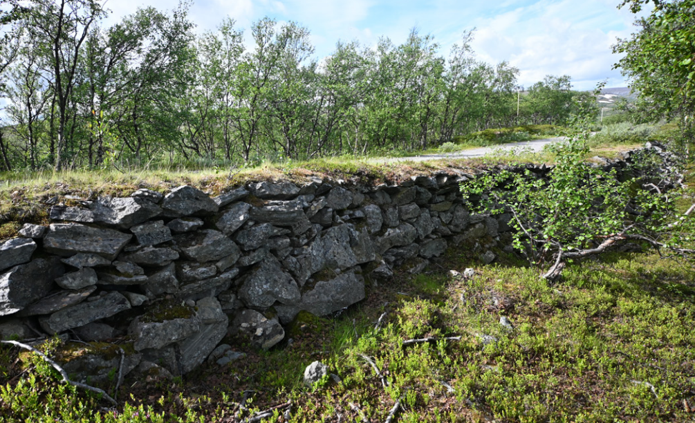
Flott vegmur bygget som del av vegkroppen på kjøreveien. Steinene bærer preg av å være brukt som de er, uten for mye tilhogging eller forming. (Foto: Nora S.K. Hansen)
