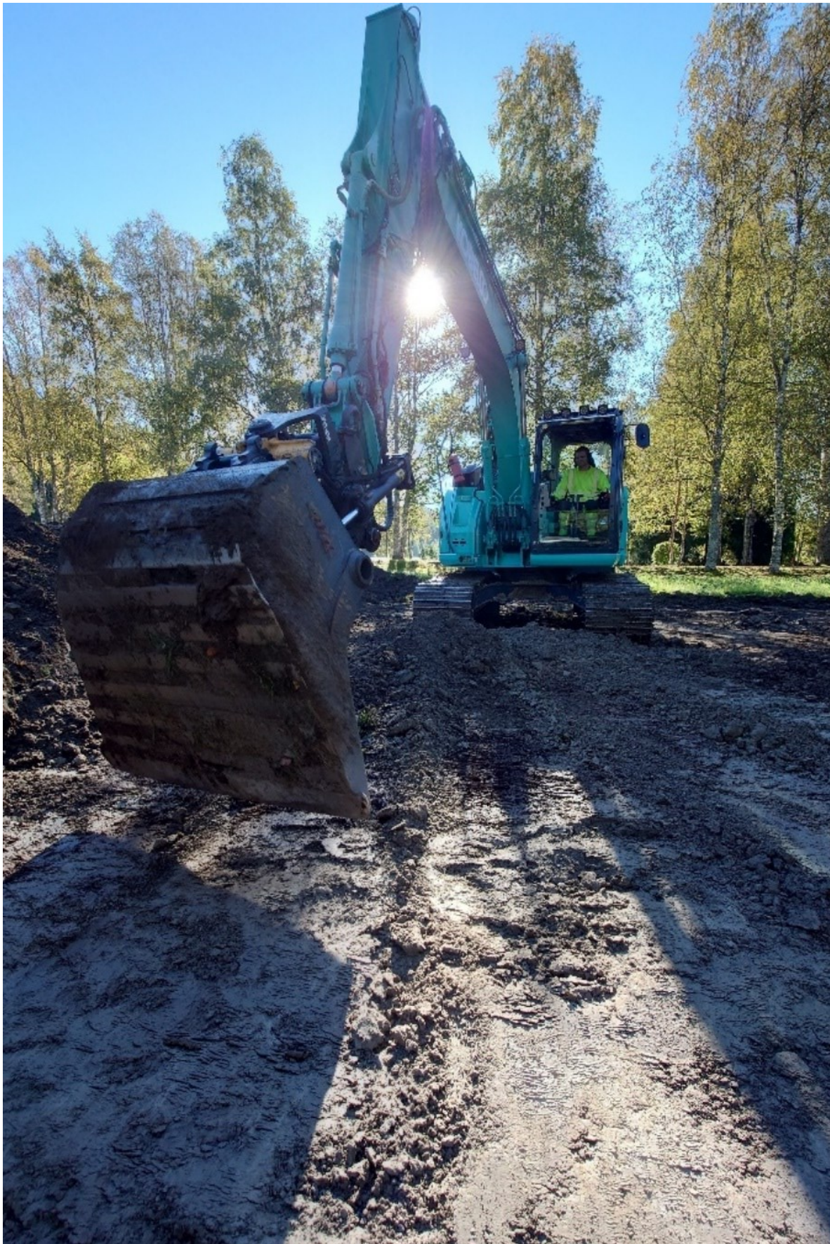
Figur 9. Schaktning vid L2023:393. Foto från nordnordväst.
