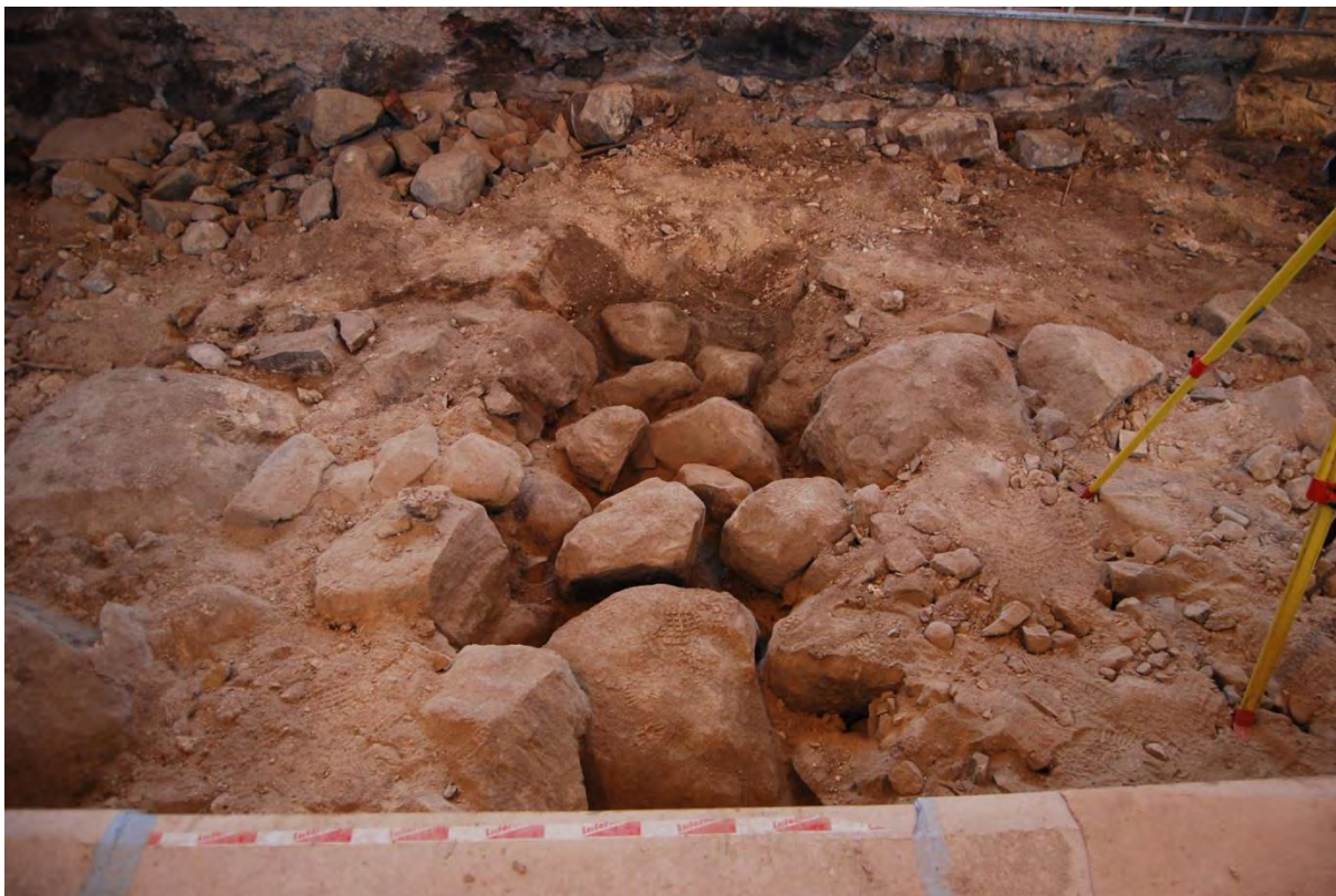
Figur 3. Sektion av grundläggningen strax öster om det nordvästra hörnet i den medeltida kyrkan framrensad. Foto från söder.
