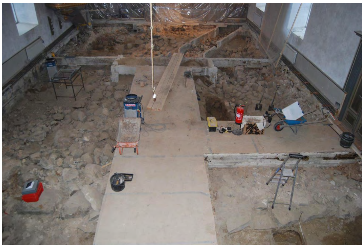
Figur 10. Grunden till den medeltida kyrkan framrensad. Flera betongbalkar i koret är borttagna vid fototillfället. Foto uppifrån orgelläktaren i väster.
