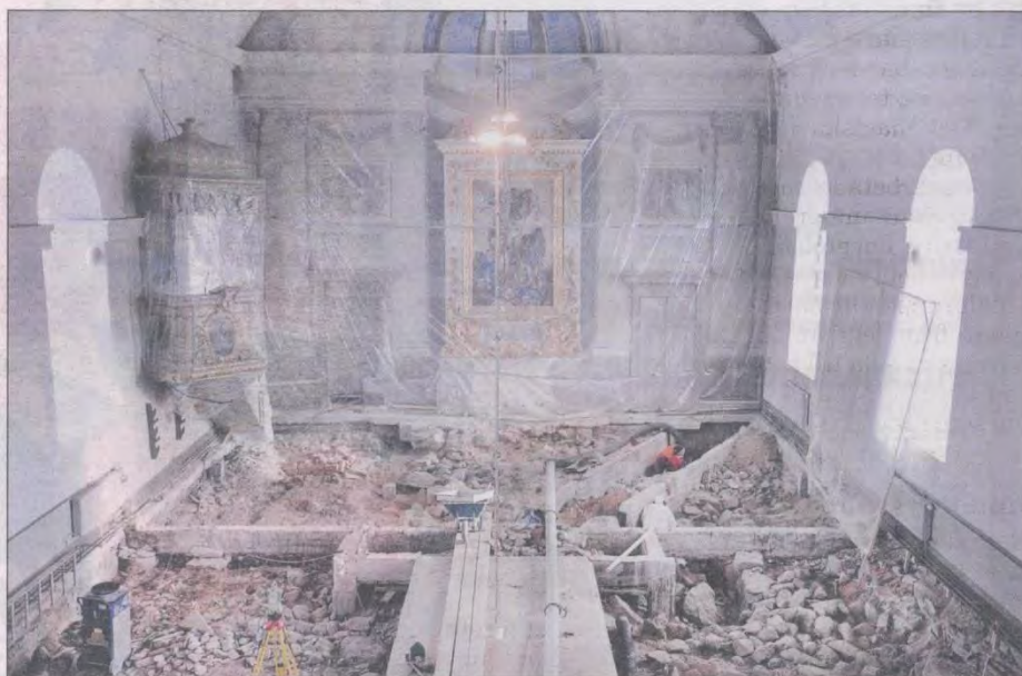
UTGRÄVNING. Innan renoveringen av det hussvampdrabbade golvet i Timrå kyrka vill länsstyrelsen veta exakt vad som finns under kyrkan. Foto: MOA FREDHOLM
