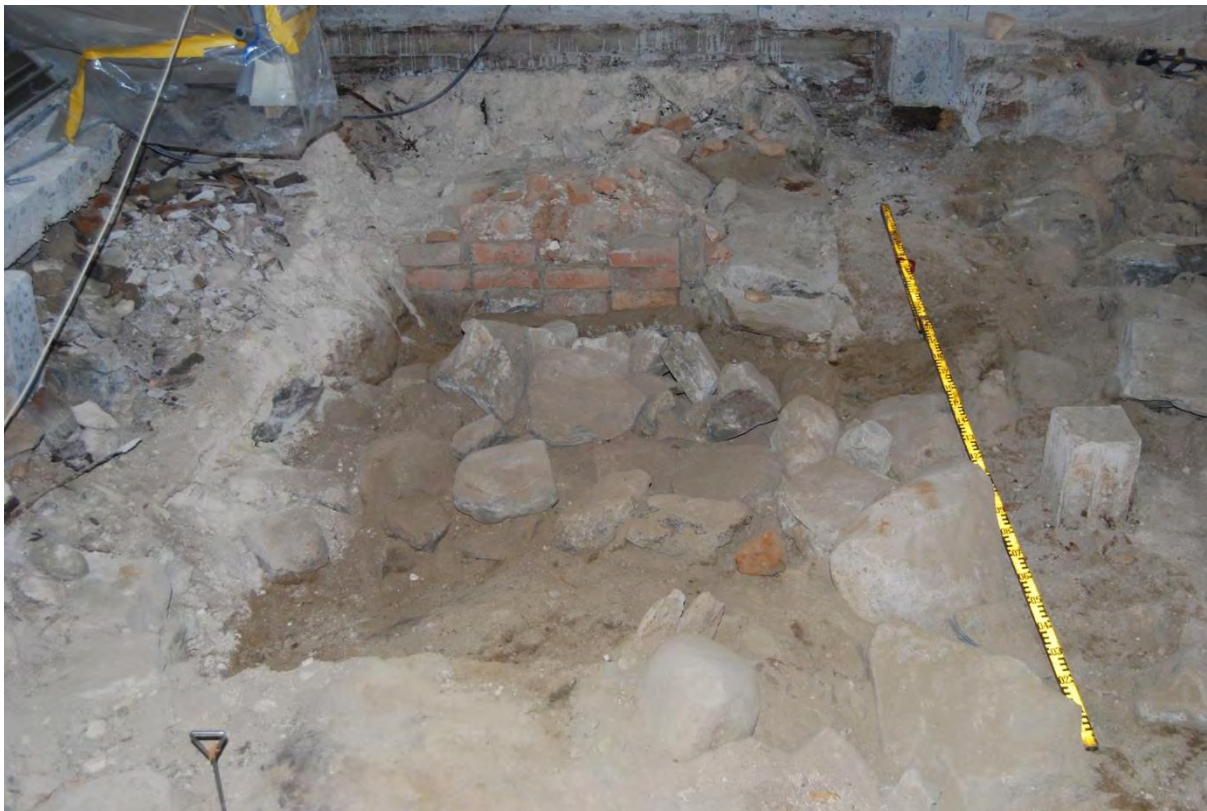
Figur 5. Öppningen i det senare medeltida korets norra vägg. Den östra delen av öppningen var murad av tegel. Foto från väster.
