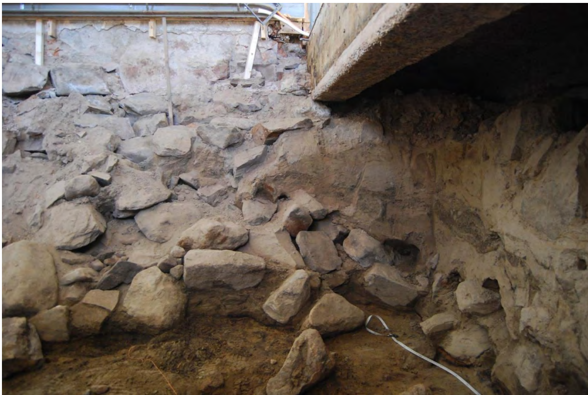
Figur 16. Markprofil under södra långhusväggen med brandlager (det mesta bortgrävt), delar av kärnröse, jordmantel samt över dessa grundläggningen till den medeltida kyrkan bestående av kantiga stenar. Foto från norr.
