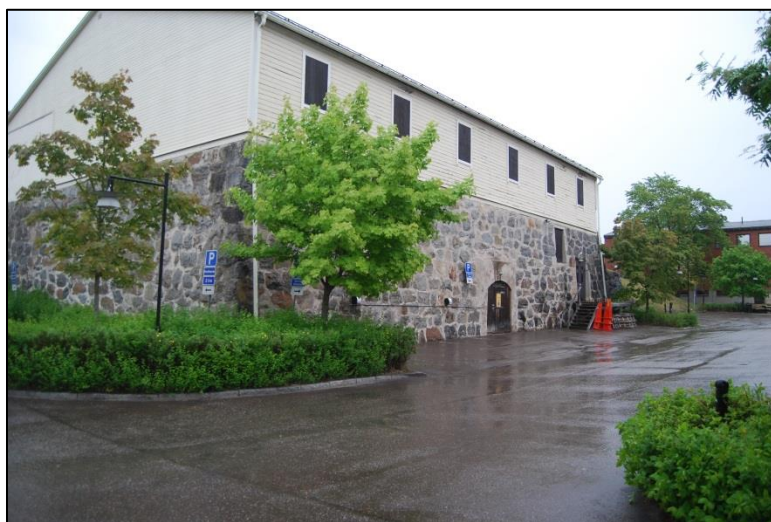
Fig. 4. Förrådet 8 (f.d. iskällare och senare färglager) och norra delen av parkeringen på fastigheten Förrådet 4. UO innan undersökning. Foto från väster, vid infarten från Sidsjövägen.
