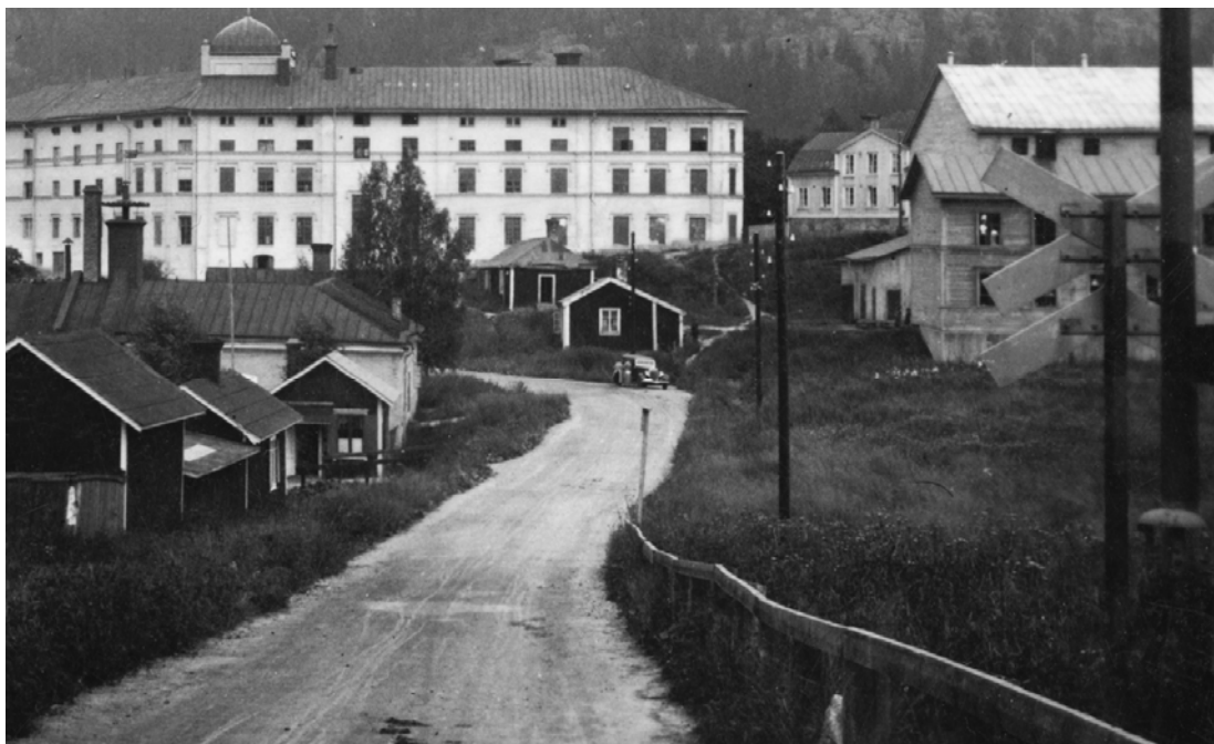
Figur 6. Foto av Sidsjövägen taget norrut mot bryggeriet. Förrådet 4 till höger, med de gamla bostadshusen. Översta våningen och taket på Strömbergs färglager sticker upp där bakom. Fotoår okänt. (Källa Sundsvalls museum)
