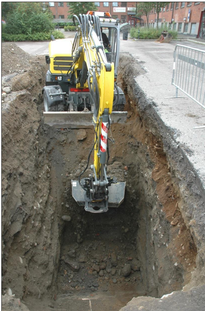
Fig. 17. Nedgrävning av schakt 8.
