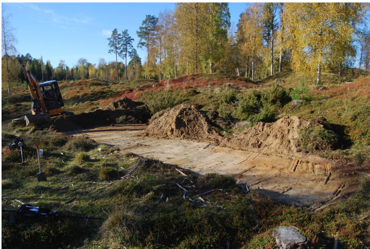
Figur 7. Det östra schaktet. Foto från sydöst.
