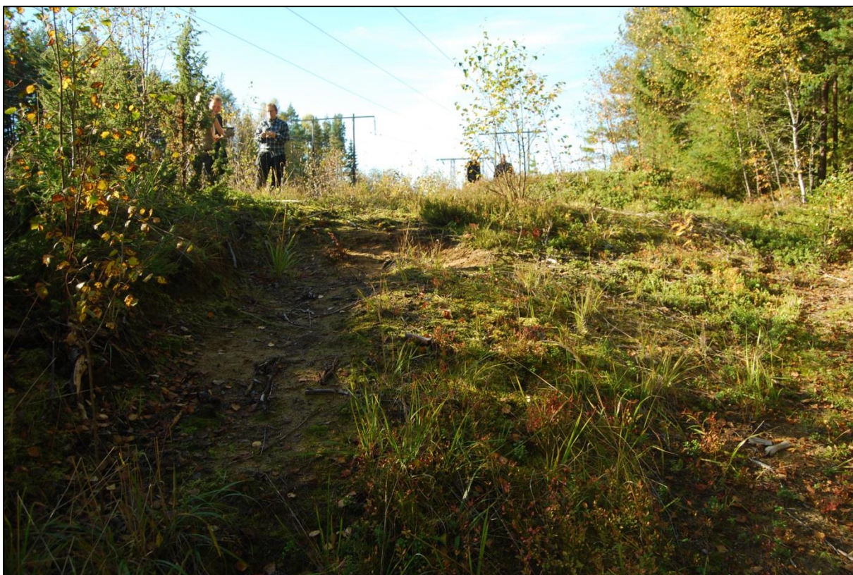
Figur 9. Schaktskada öster om graven. Foto från öster.
