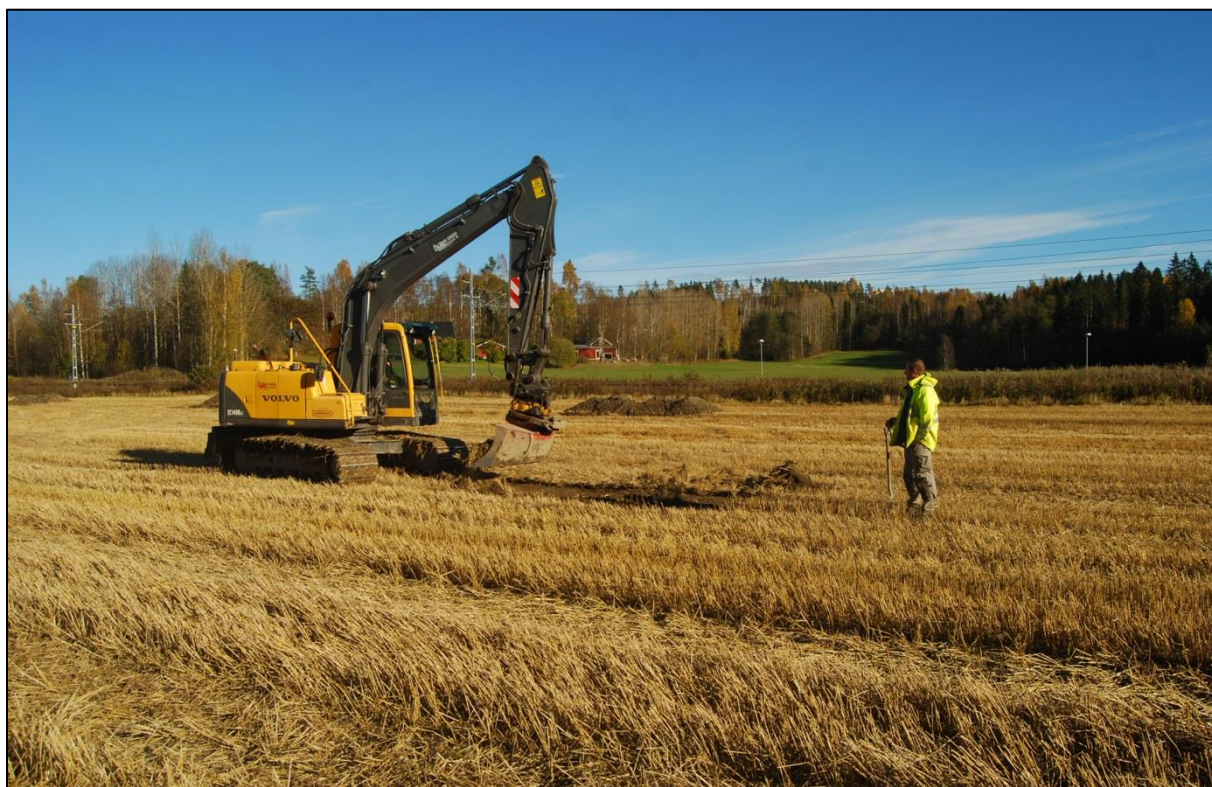
Figur 12. Arbetsbild, Ola George övervakar schaktningen. Foto från sydväst.
