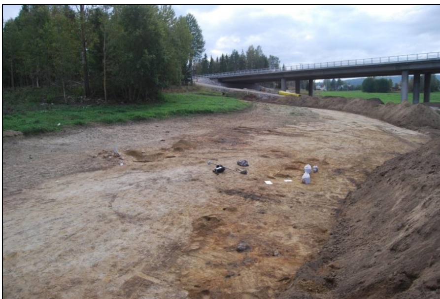
Figur 10. Översikt av schaktets västra del. I bakgrunden nya E4. Foto från öster.
