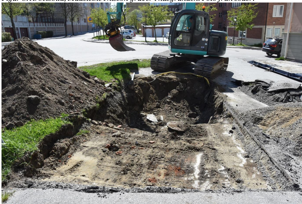
Figur 9. Det sydliga, omrörda schaktet under grävning. Foto från nordöst.
