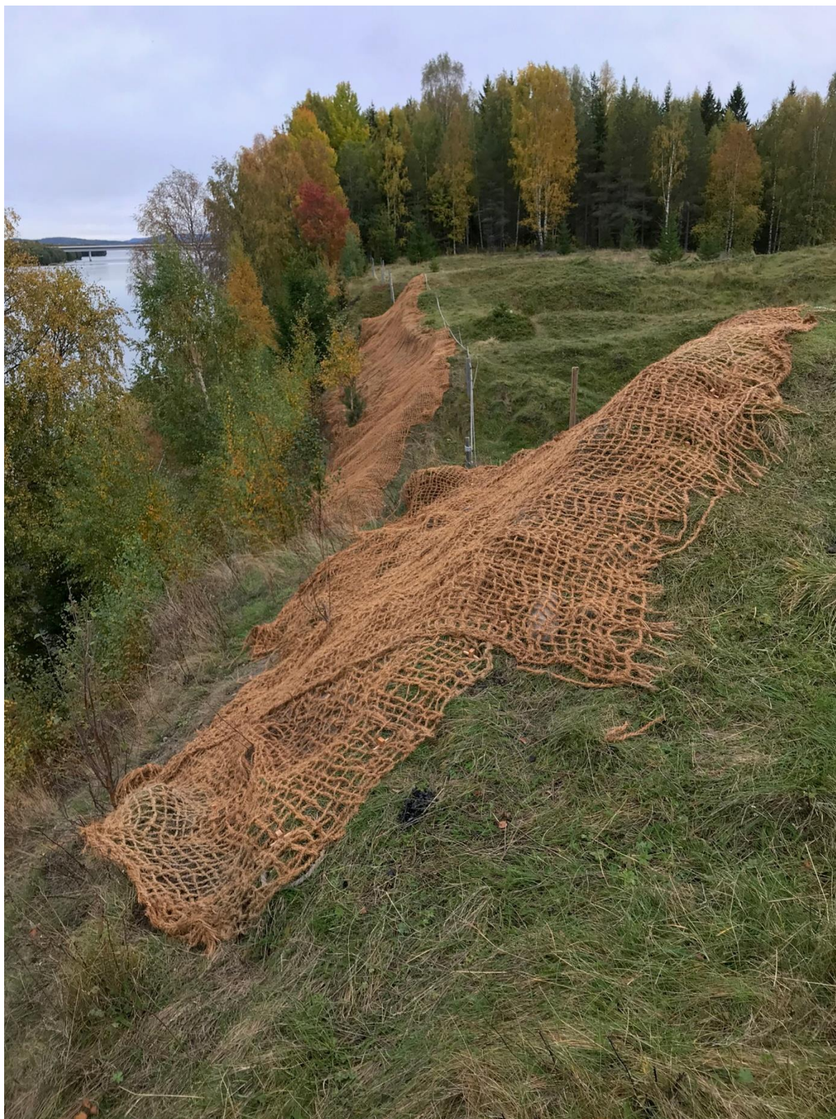
Figur 40. Norra borgkullarna efter avslutat arbete. Foto från norr.
