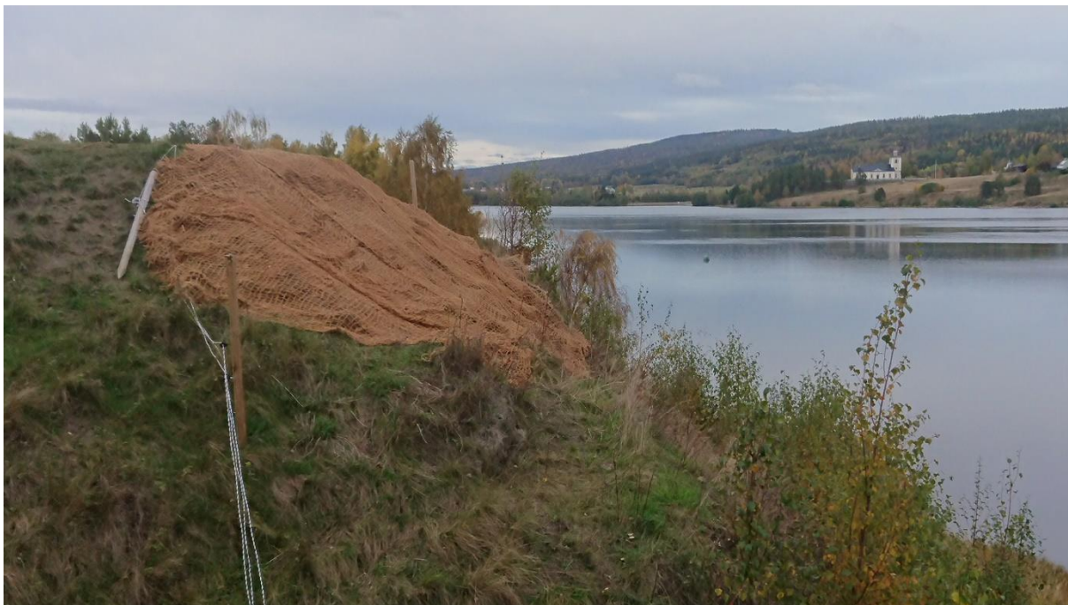
Figur 39. Norra borgkullen efter avslutat arbete. Foto från söder.
