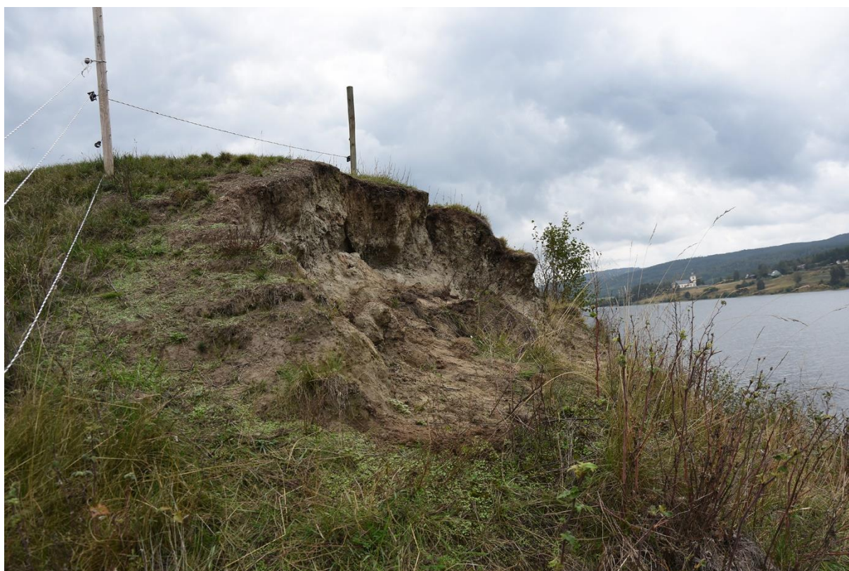
Figur 31. Eroderad del av sydöstra delen av norra borgkullen. Foto från söder.
