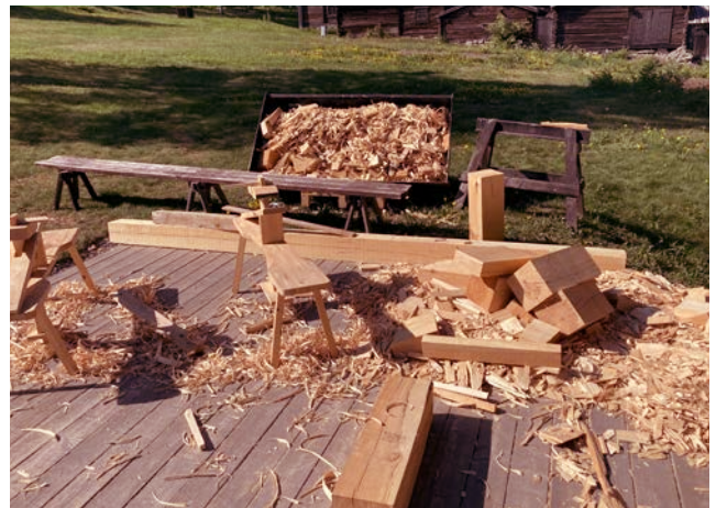
Bild från arbetsytorna vid stolpverkskursen. På kursen tillverkas strävor, överliggare, hammarband och hörnstolpar.
