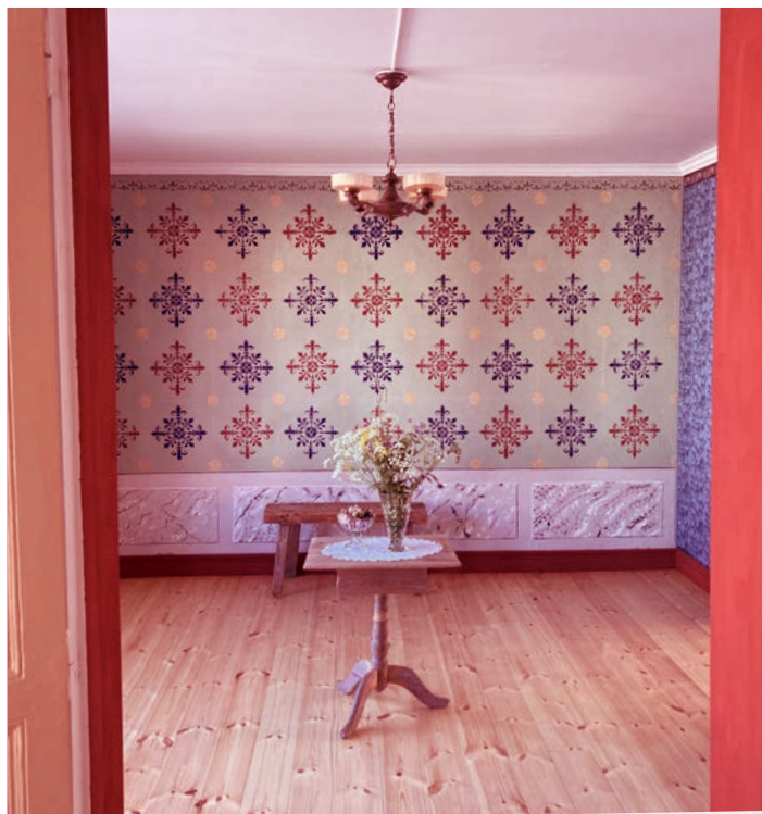
I detta rum i Hellströmska huset har Träakademin schablonmålats på lerklining samt satt upp limfärgstapeter på pappspänd vägg. Lister är målade med äggoljetempera.
