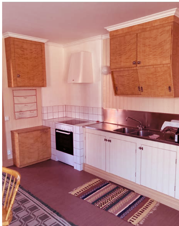
Köket är uppbyggt av återvunna delar så långt det är möjligt. Köket är genomgående målats med linoljefärg för att efterlikna ett kök från ca 1930.
