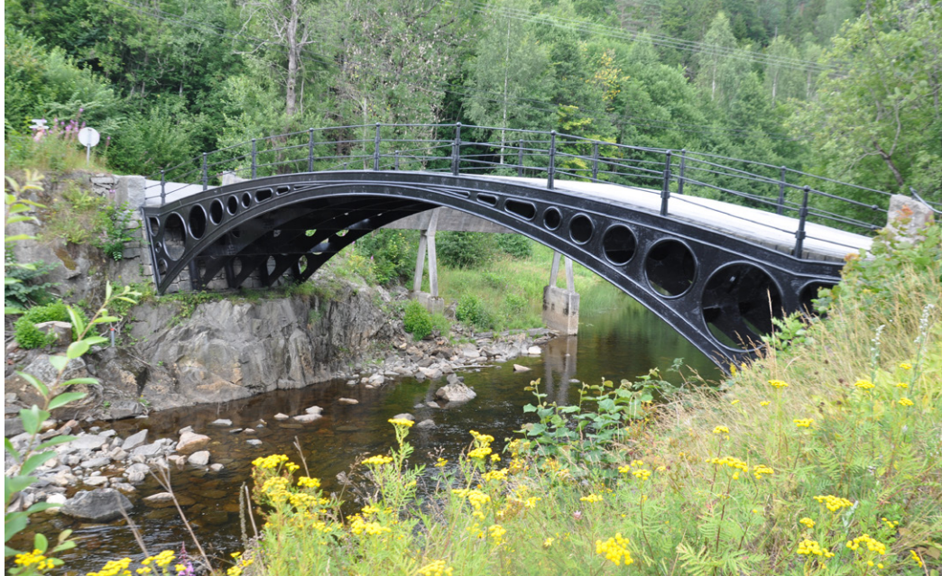
Fosstveit bru, ei av to støypejernsbruer i Norge. Denne vart støypt på nærliggande Nes jernverk i 1836. (Foto: Håkon Aurlien)
