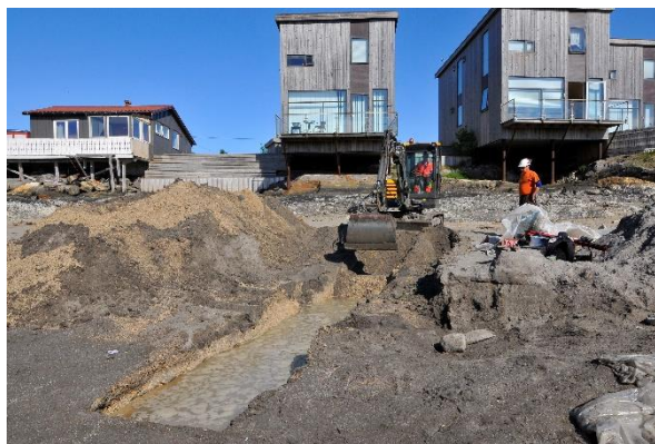
Figur 7 Graving av profil mot nord 13. juni 2017. Kestutis Alminas håndterer gravemaskinen, og Stephen Wickler (t.h.) overvåker gravingen. Foto: T. Falck/NMM.
