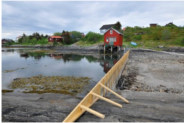
Figur 12 Provisorisk forhøyning av muren på grunn av forventet høyvann 11. juni. Foto: T. Falck/NMM.
