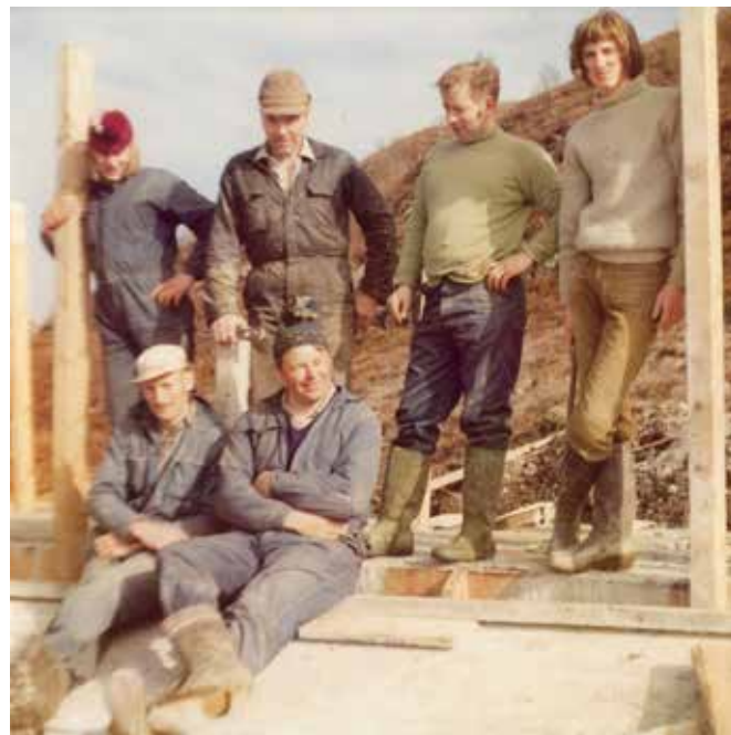
Dugnadsgjengen som var med å gjennomføre bygging av ny skytebane i Aksetdalen. (Foto Annbjørg Ludvigsen)
