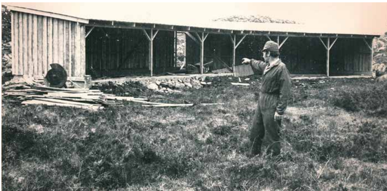
Nils Kr. Fjeldvær var byggeleder og meget sentral i utbyggingen i Aksetdalen.
