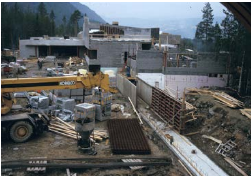
Museumsbygningen tek form i 1990. Fram mot høgre ser ein betonggangen som bind saman Lysaker med museumsbygningen. (Foto: Aslak Stø)
