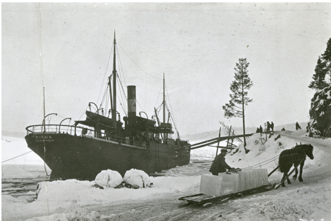
De første dampskipene kom tidlig inn i iseksporten, men ikke før 1911 var det mer dampskipstonnasje enn seilskipstonnasje i den norske isfarten. Først etter 1. verdenskrig var dampskipene tilnærmet enerådende. Her laster DS «Firda» av Stavanger is fra isanlegget i Lagdalen ved Leangbukta i Oslo i 1925. Foto: ukjent. Tilhører Norsk Maritimt Museums fotoarkiv.
