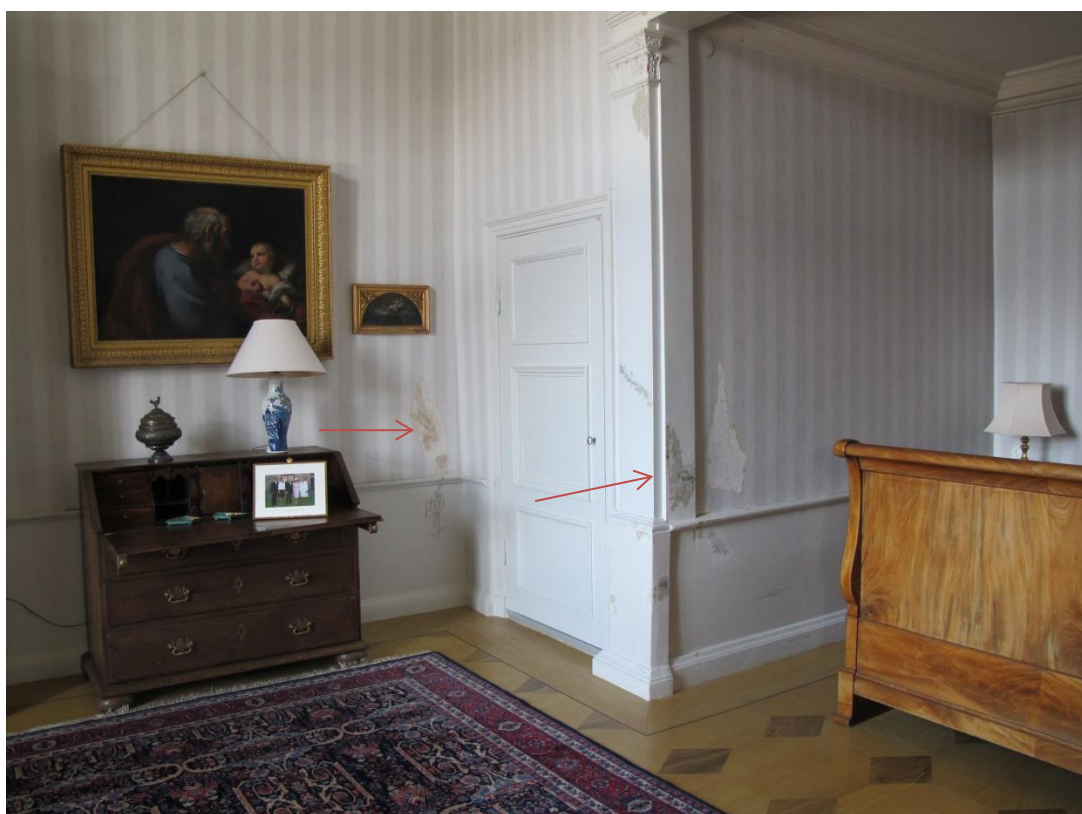
Bild 2: Pilarna visar underliggande ytskikt på vägg respektive marmorering på alkovens omfattning, förundersökning 2013.
