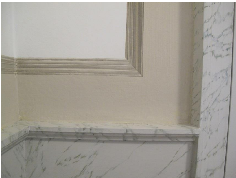
Bild 14: Närbild marmorering och väggfält efter målning.
