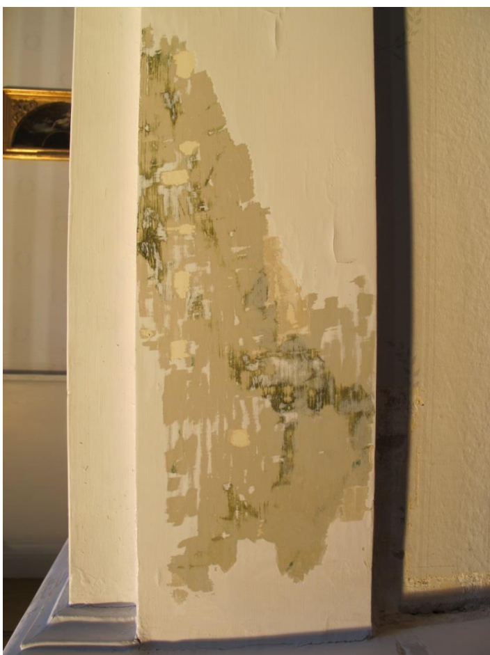
Bild 4: Framskrapad yta på alkovens omfattning. Snickerier, liksom bottenkulören i marmoreringen kring alkoven var målad med en grågrön kulör. Marmoreringen på alkovens omfattning var utförd med en mörkare grön marmorering än på övriga snickerier, förundersökning 2013.
