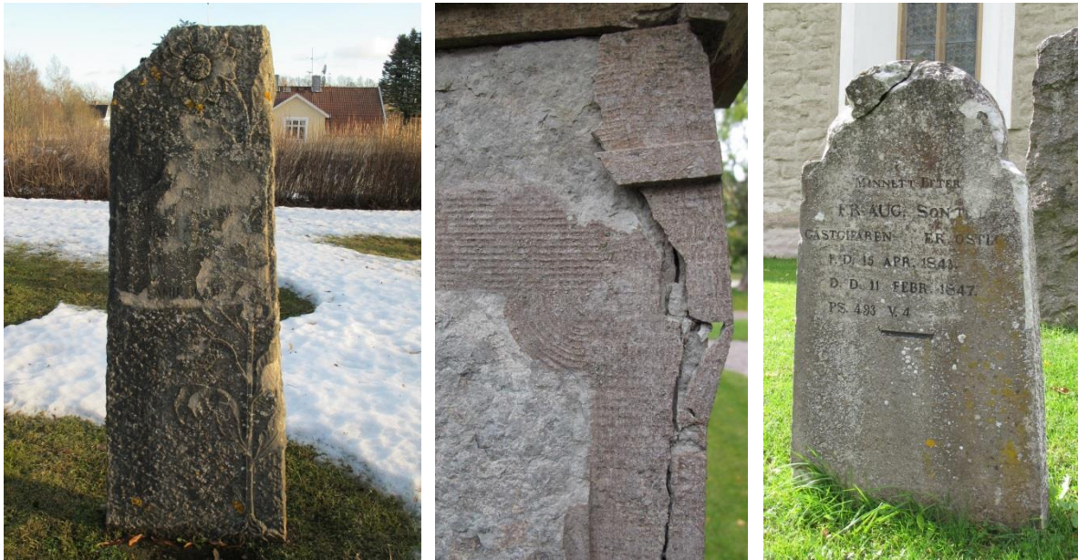
Bilderna ovan visar på olika skador som flera av gravvårdar av kalksten kan ha. Vittring, skador efter frostsprängning, sprickor m.m.
