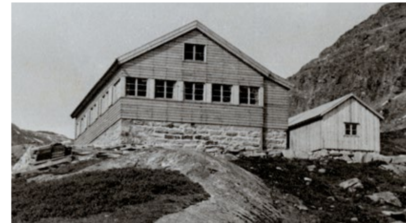
Vindusrekken på Nørdstedalseter (1937, arkitekt Henrik Nissen) går helt ut og rundt hushjørnet og viser funksjonaldetaljer til fjells. Bildet er fra 1958.
