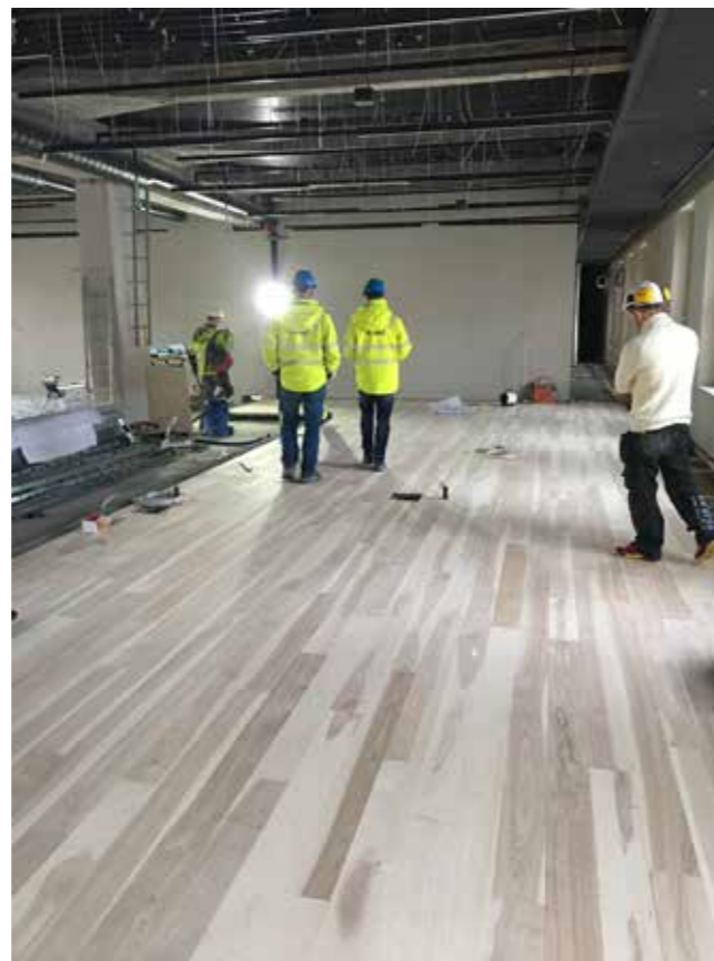
Askegulvet ferdig lagt.
