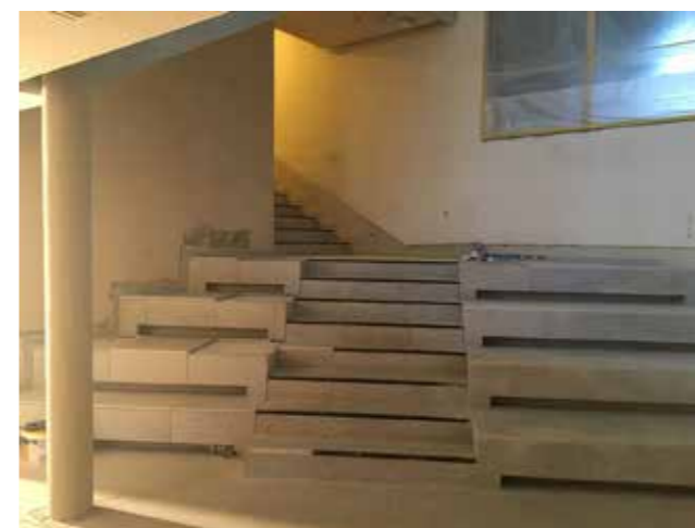
Trapp og amfi i vestibylen. Terrasso støpes og legges.
