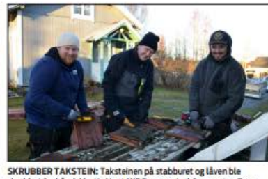
SKRUBBER TAKSTEIN: Taksteinen på staburet og låven ble skrubbet for hånd. Martin Vogt (KF Byggservice) fra venstre, Even Bratlie Jørstadengen og Kenneth Blinderen (begge Roald Larsen AS) gikk på med stålborste og godt mot.
