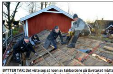
BYTTER TAK: Det viste seg at noen av takbordene på låvetaket måtte byttes. Det ga god øvelse for f.v. Per Ivar Moen (daglig leder Grendebbygg), Espen Kolting (snekker i Eiendoms), Martin Waltoft (tømrer i Grendebbygg) og Knut Foldvik (tømrermester/takstmann).
