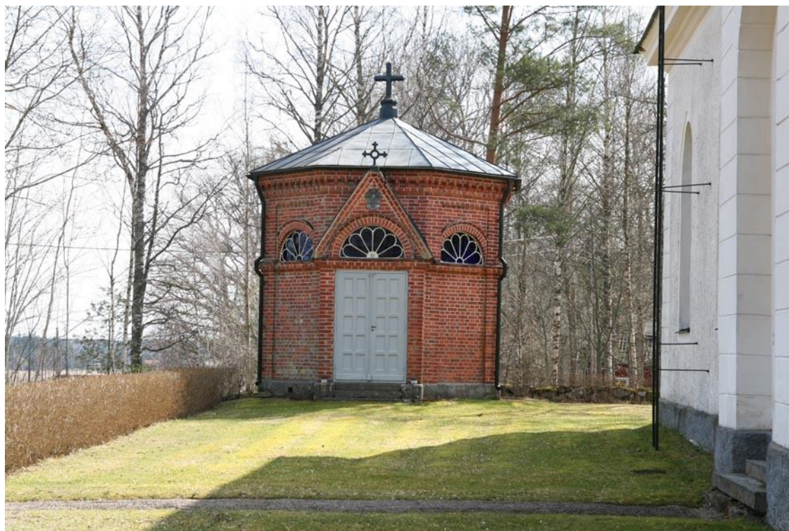
Det von Engeströmska gravkoret står nära kyrkans nordöstra hörn. Det är ett fint exempel på 1800-talet tegelbyggande i nygotik.
