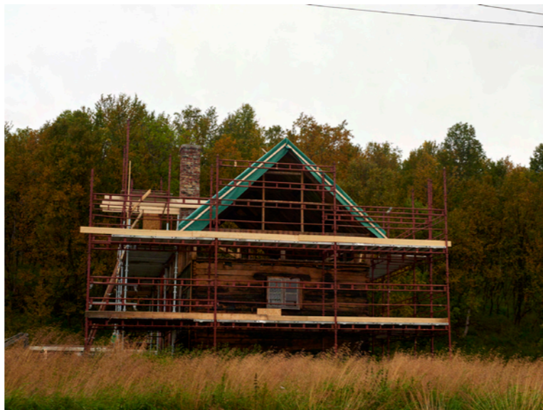
Byggmester M. Paulen AS satte opp stillas rundt begge husene. Her er fjøset i Indre Billefjord under demontering i slutten av august 2016. Utvendig kledning er fjernet, men taket er stadig dekket med presenning. Bildet er utstilt i Porsanger rådhus. Foto: Bjørn Tore Pedersen.
