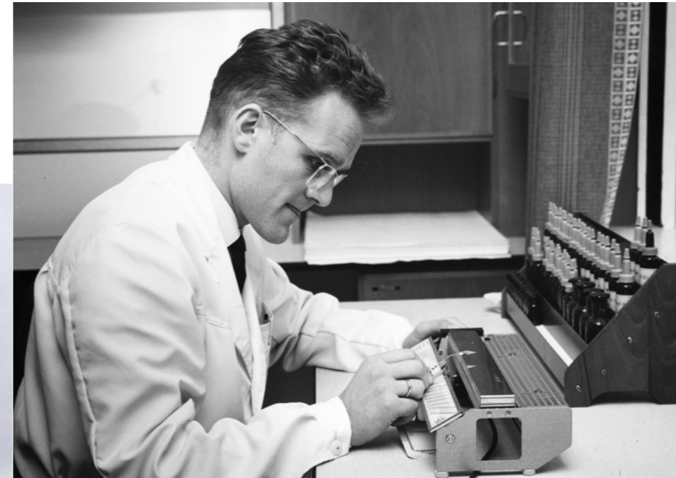
Apparat til smeltepunktbestemmelse (Kofler-Heizbank) var blant utstyr som kom i forbindelse med krav om identitetsprøver av råvarer. Fra apotekteknikerlinjen, Oslo elementærtekniske skole, 1964. Foto: Sjur Fedje, Arbeiderbladets billedavdeling/Norsk Folkemuseum
