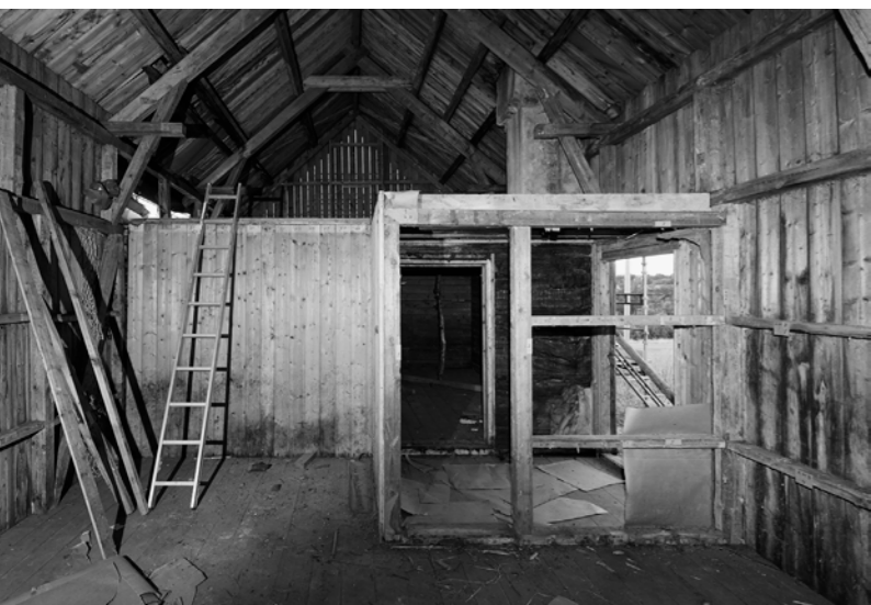
Fjøset fra Indre Billefjord var todelt. Selve fjøsdelen var laftet mens låvedelen var bygget med bindingsverk. Det var et vindfang mellom fjøset og låven. Her ser vi fra låvedelen gjennom vindfanget og inn i fjøset. Kledningen på vindfanget og trappa opp til «trevet» over fjøset er fjernet.
