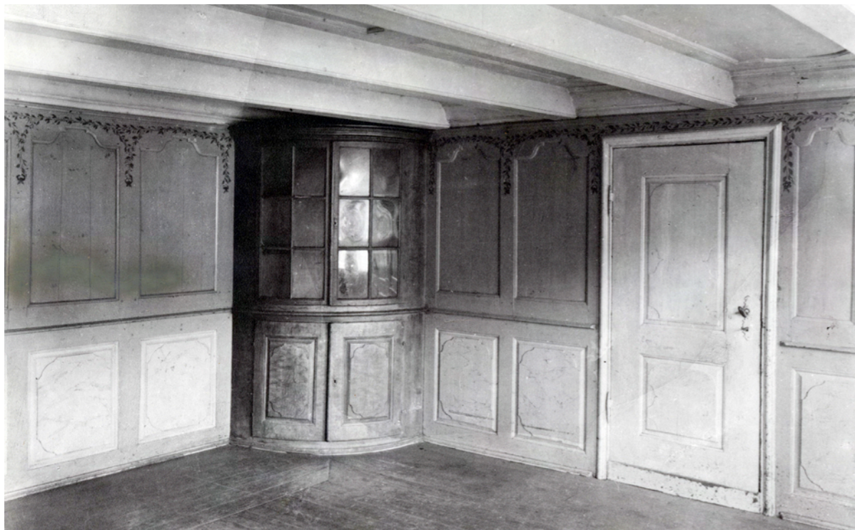
Knud Nordbergs storstue på Strømmen i Arendal. Han kjøpte eiendommen av sin far i 1779 og bodde her til sin død i 1810. Bildet viser malte vegger med dekor fra tidlig 1800. Da rommet ble gjenreist på museet, ble vegger og tak lutet. Foto: Norsk folkemuseum.
