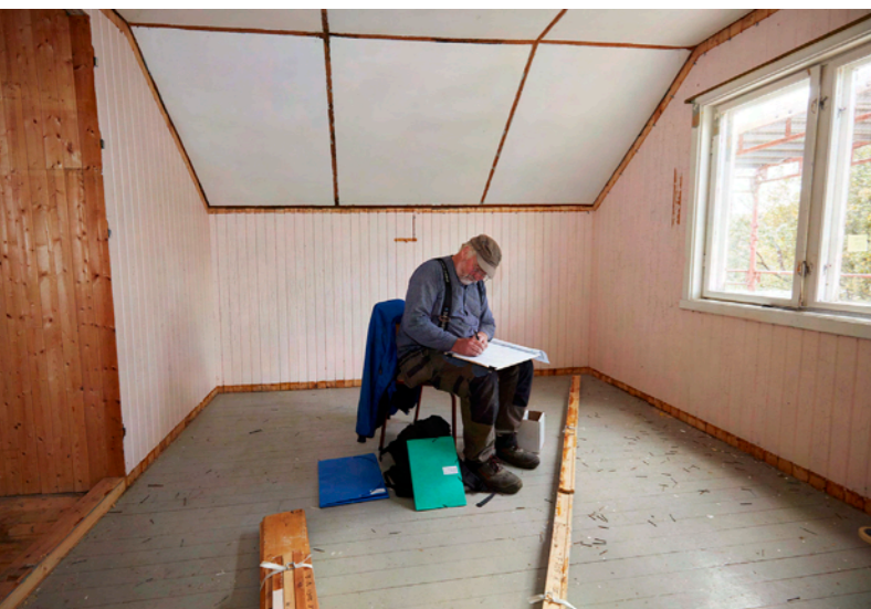
Alle rommene ble nummerert og veggene fikk en bokstav. Videre fikk alle bygningsdelene sin merking og plassering i dette systemet. Her sitter Ole Jørgen Schreiner fra Norsk Folkemuseum i et av soverommene i Olderfjord og registrerer listverk. Bildet er utstilt i Porsanger rådhus.
