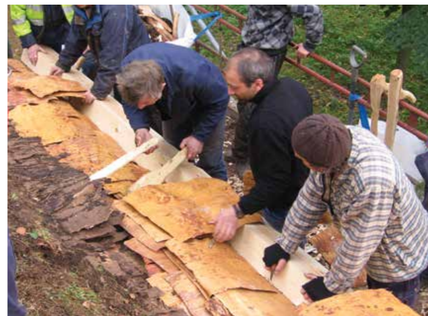
Vøling av nevertak på Sagastua. Foran fra høyre: Edvard Undall, Trond Oalann og Steinar Mølster med «trespadene». Foto: Christian Winther-Larsen, Norsk Folkemuseum.
