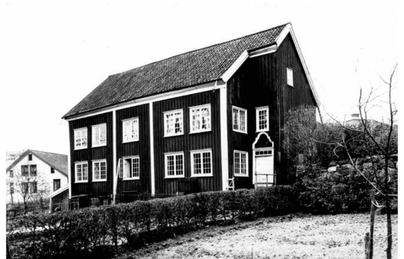
Strømmenhuset fotografert fra sjøsiden. Øyestadbilde nr. 15. AAKs.
