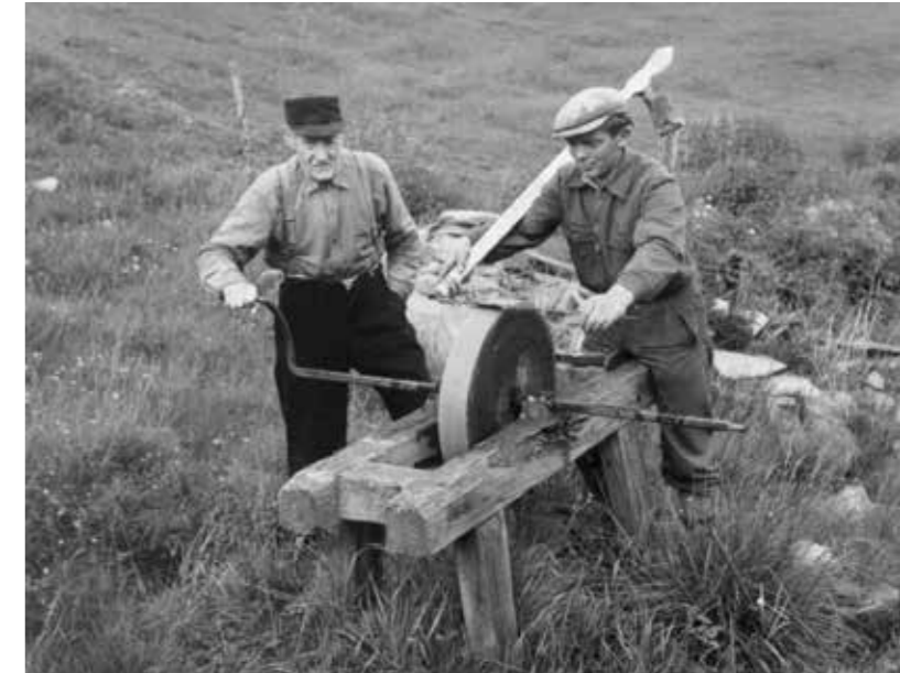
Sliping av ljà på slipestein.
