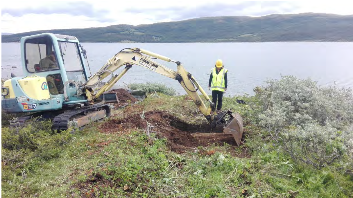
Figur 6 Utgravningsmetode. Fjerning av torv i felt A. Den nordre vollen er synlig i forkant av gravemaskinen. Bilde tatt mot øst. Foto: NMM/Elling Utvik Wammer.
