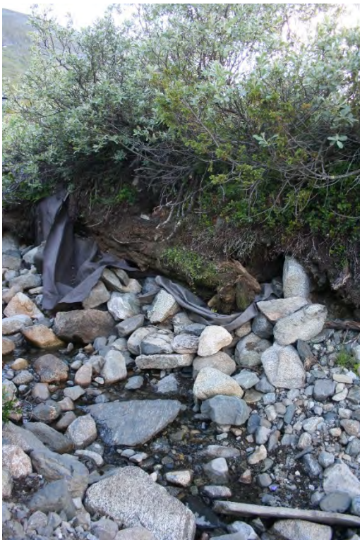
Figur 48 Nausttufta i bekkefaret, sikret med stein og fiberduk. Bilde tatt mot Ø. Foto: NMM/Elling Utvik Wammer.
