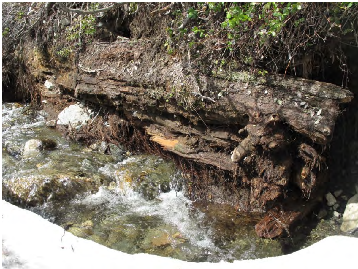
Figur 3 Søndre langvegg og pågående erosjon under vårmeltingen i 2014. Foto: OFK.
