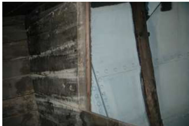
Tverrskott baug. Foto: M.Hjelløy
