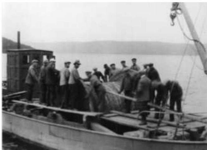
Et av få foto av "Brandbu" i bruk. Kabellegging 1923. Foto: Hadeland Energi
