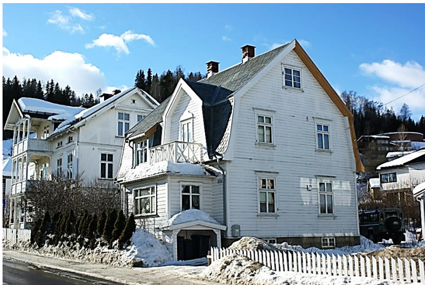
Hans Mustadsgate 11a i Gjøvik har vernegrad 3. Skifertaket er restaurert med tilskudd fra Norsk Kulturminnefond
