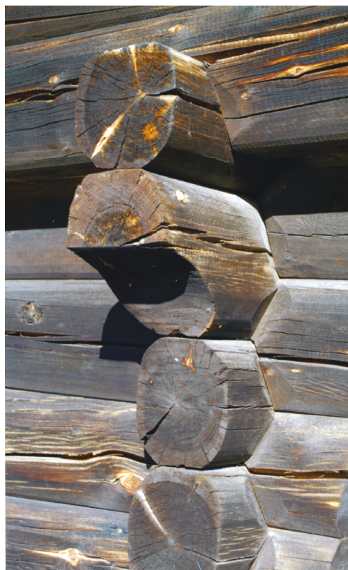
Ei av novene på stabburet viser at Ola kunne sitt handverk. Nova er hogd tett sammen.
