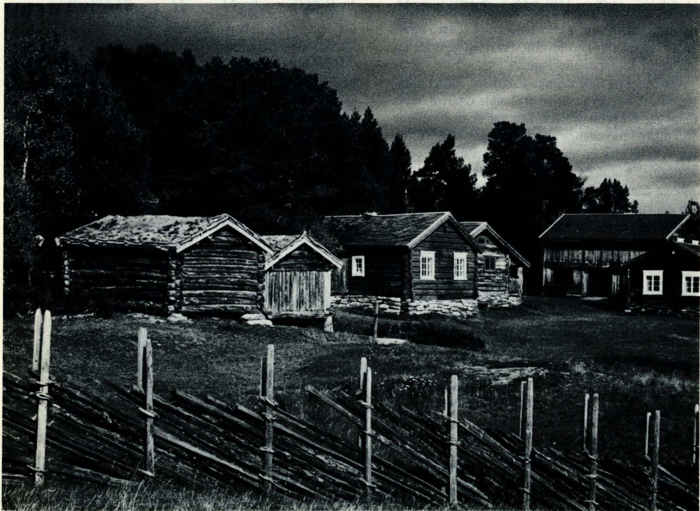
Streitlien Uppigard, Folldal Bygdetun. T.v. er Folldalsgarden under oppføring, med uthus fra Dalåsen, bl.a. ei sjelden stavløe, stua fra Lonasetra er også oppført nå. Mye av arbeidet er gjort på dugnad av museumsstyret. (61985).
