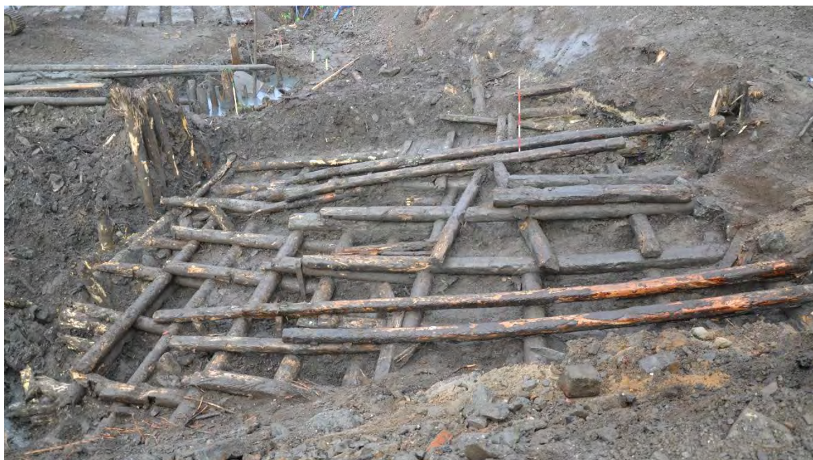
Figur 74: Oversikt over bolverk K17 på A8. Foto tatt mot NV av Andreas Kerr, NMM.
