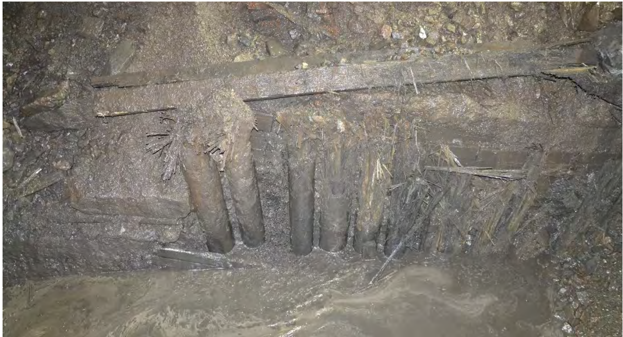
Figur 35: Foto av overgangen kaifronten av Jernbanebryggen fra betongfront (til venstre) til trefront (til høyre). Foto mot NØ av Marja-Liisa P. Grue, NMM
