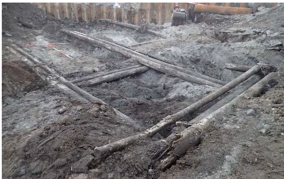
Figur 83: Søndre del av den bevarte delen av K40. Foto tatt mot V av Tom Davis, NMM
