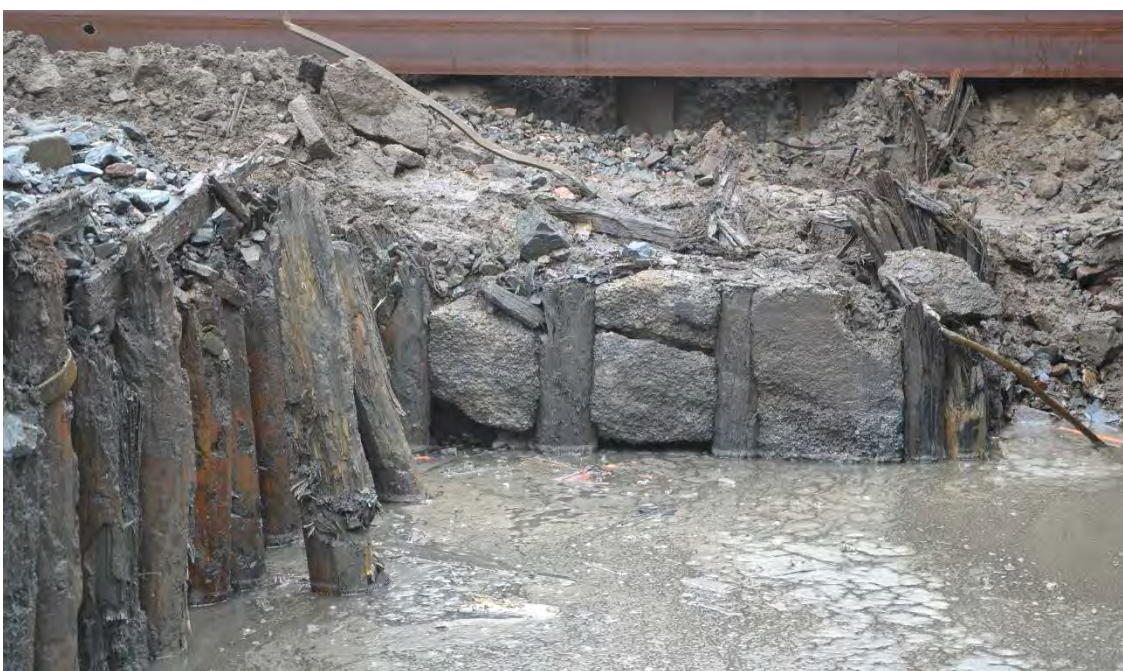
Figur 41: Hjørnet av slusen i betong som gikk ut fra trefronten av Jernbanebryggen (til venstre i bilde). Foto tatt mot Ø av Sven Ahrens, NMM.
