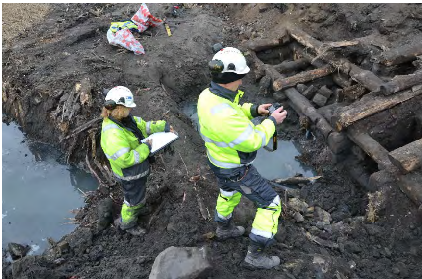
Figur 11: Dokumentasjon av bolverk på A8 ved hjelp av fotogrammetri og innfylling av konstruksjonsskjema. Foto av Andreas Kerr, NMM
