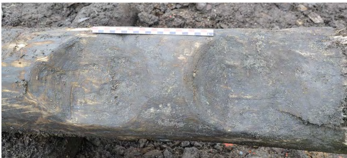
Figur 92: Eksempel på doble enkle laftehugg fra K30. Foto av Khalil Olsen Holmen, NMM
