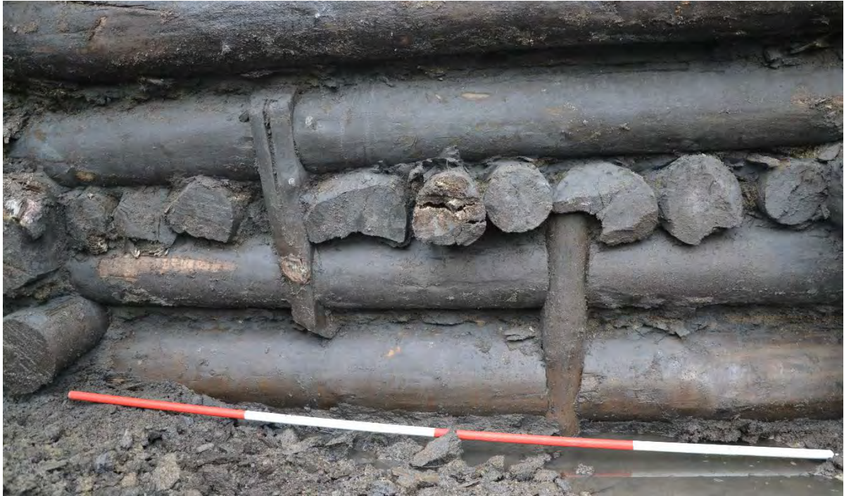
Figur 95: Vertikale rektangulære trebiter innfelt i stokkene i bolverk K30, i den ytre vestre kanten, blant annet delvis gjennom et midte gulv/dekke. Foto tatt mot Ø av Sven Ahrens, NMM.
