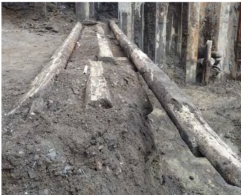
Figur 44: Fundament til K35 og K36 bestående av tre parallelle stokker. Foto tatt mot Ø av Marja-Liisa P. Grue, NMM.
