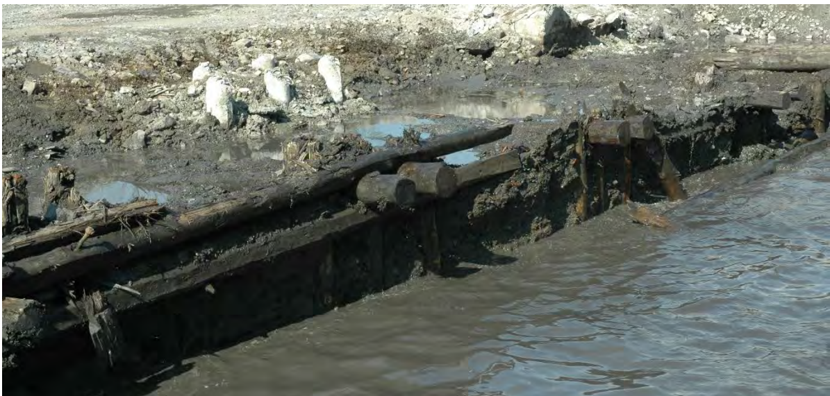
Figur 34: Bakre forankring av Jernbanebrygga, målt inn som K3 i felt. Foto tatt mot SV av Marja-Liisa P. Grue, NMM
