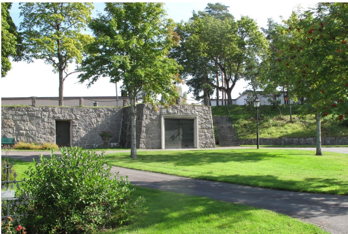
Integrerat bisättningsrum i östra muren, södra utvidgningen. Muren med bisättningsrummet tillkom i mitten av 1950-talet.
