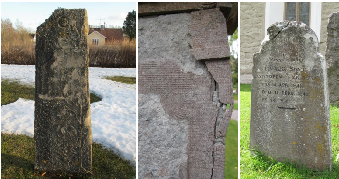
Bilderna ovan visar på olika skador som flera av gravvårdar av kalksten kan ha. Vittring, skador efter frostsprängning, sprickor m.m.
