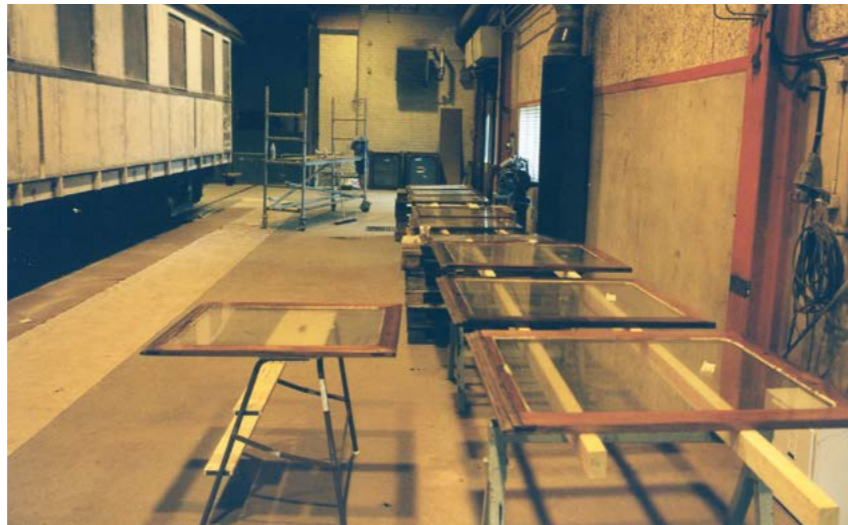
Fönster till Co9b 2798 efter slipning, 1998. Foto: Thom Olofsson
