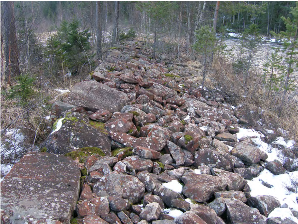
Like på oppsiden av smelteplassen er det i nyere tid bygd en elveforbygning for fløtingen. Det er mye stor naturstein i området, men kanskje kan stein fra smeltehytta ha vært benyttet? (Foto: B.I.Berg 16.01.2007)
