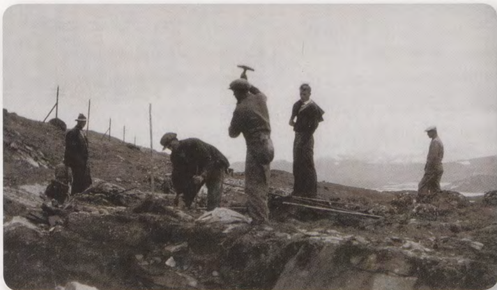
Anleggsarbeid på Sognefjellsvegen i 1938. Foto: Norsk vegmuseums fotoarkiv.
