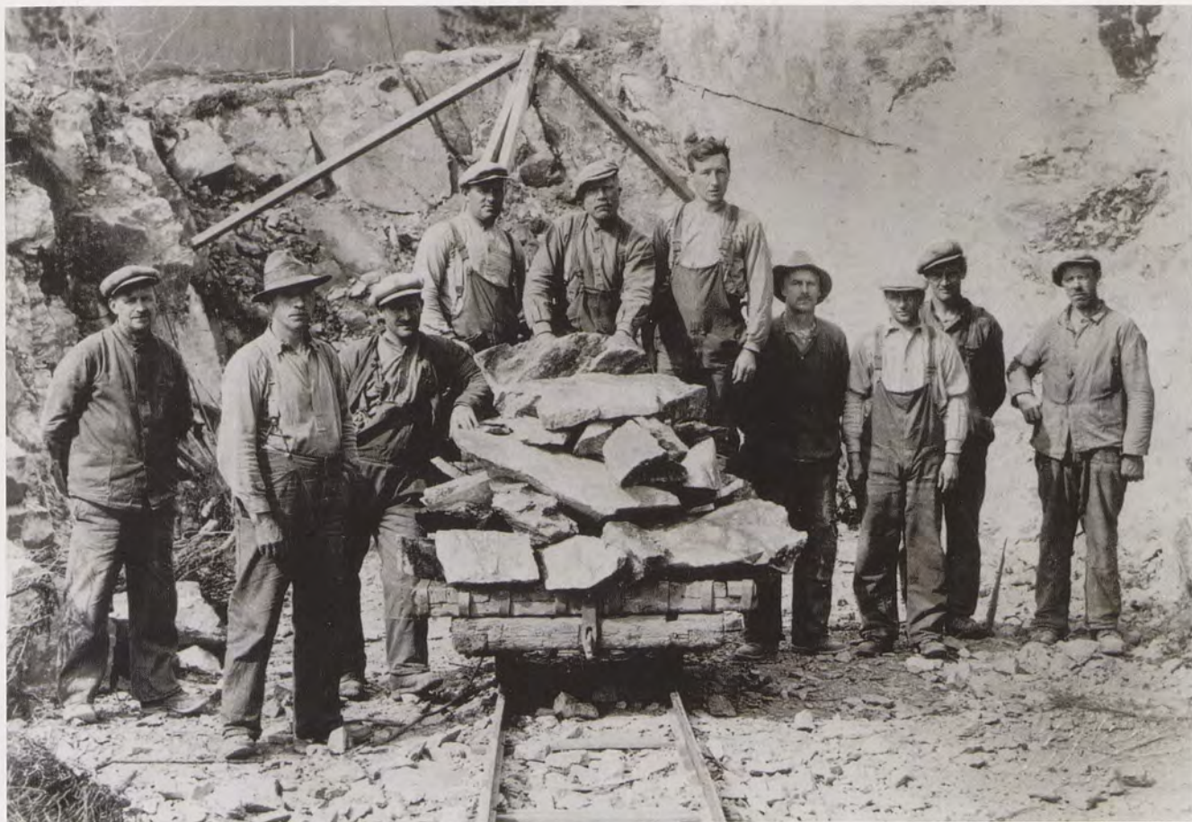
Vegarbeid ved Follafoss i Nord-Trøndelag 1935, med vagge, tralle, skinnegang og stubbebryter, typiske arbeidsredskaper i anleggsdriften i 30-årene. Foto: Norsk vegmuseums fotoarkiv.
