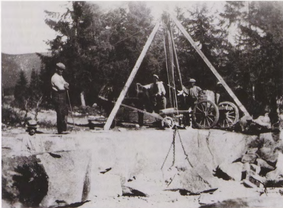
Stubbebryter var det eneste hjelpemiddelet ved tunge løft. Motivet er fra Rv. 316 Steinholt–Siljan i Telemark, fra perioden 1930-36. Foto: Norsk vegmuseums fotoarkiv.
