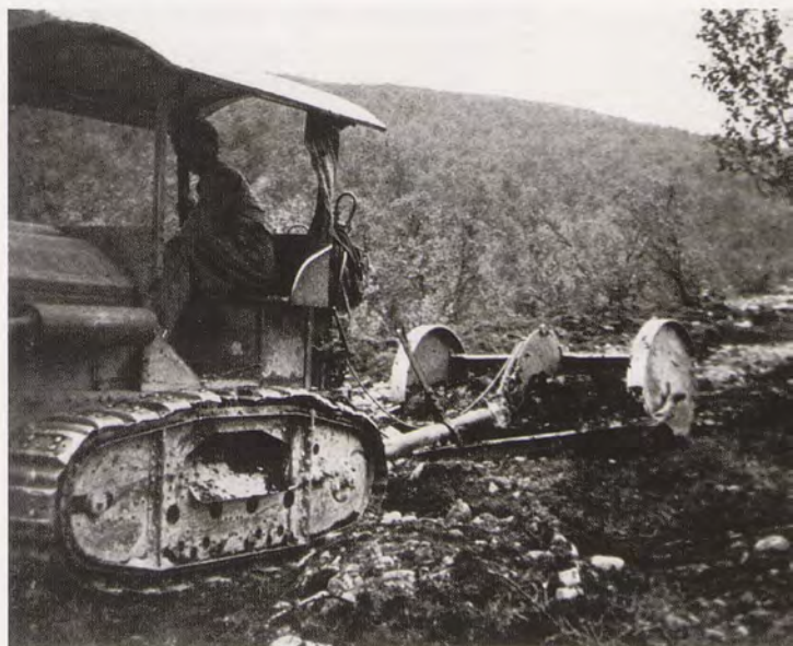
Hannomag beltetraktor brukt med slepeskrape i Lebesby, Finnmark, i 1939. Foto: Norsk vegmuseums fotoarkiv.
