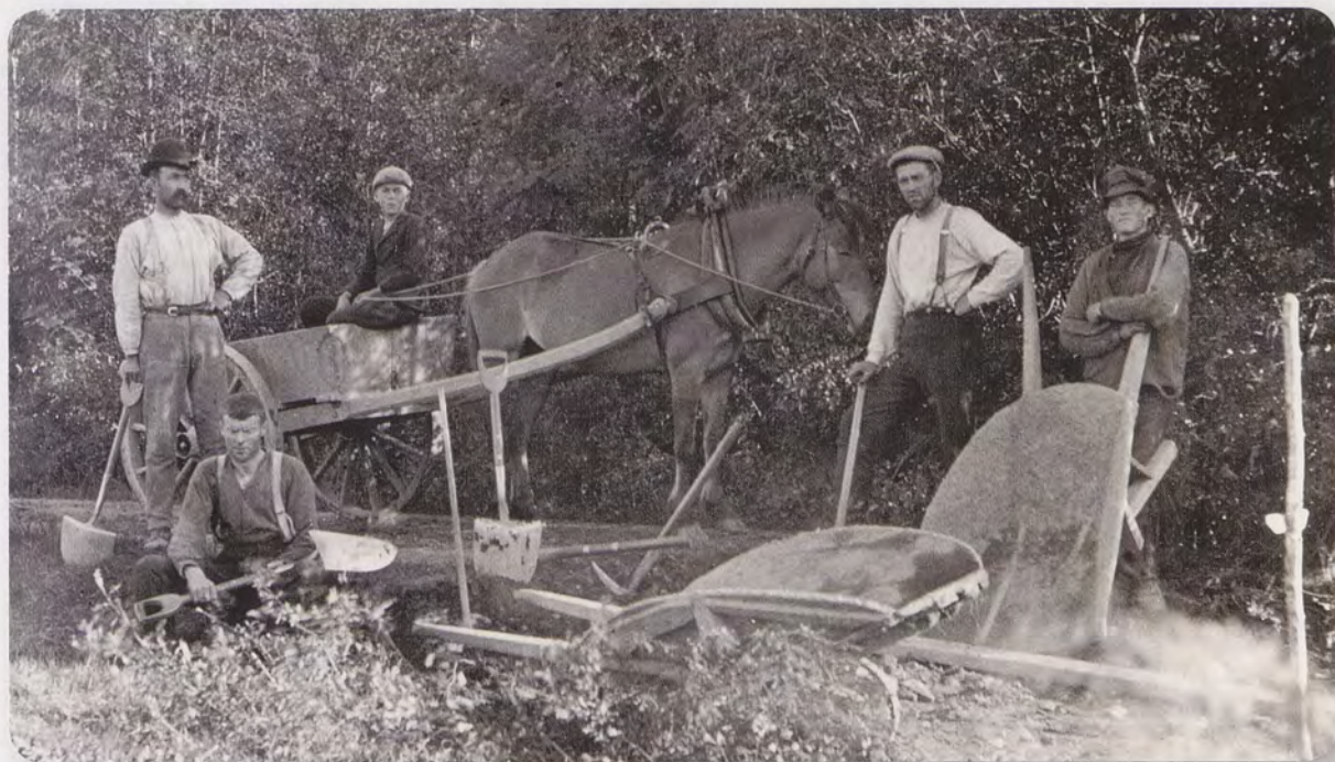
Det var arbeidsintensiv drift ved veganlegg og vegvedlikehold. Vegvokterne hadde sine vegvokterbåre og håndredskaper. Bildet er fra Nord-Trøndelag i 1913, på vegen Veieskorsen-Semskorsen, Myrslomarka, Henning. Fra venstre på bildet formann Albert Moen (senere stortingsmann for Ap), Nikolai Myrslo, Johan Moen, Toralf Moen. Gutt med hest og kjerre i bakgrunnen. Foto: Norsk vegmuseums fotoarkiv.
