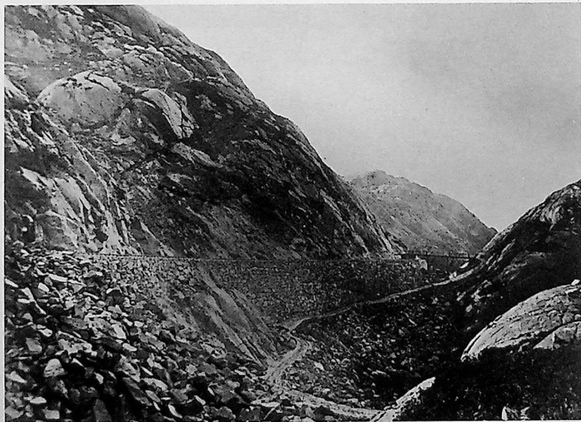
Blåfjellbanen. Bilde tatt ved veien til Aursland og viser et midlertidig lastearrangement som ble brukt før den siste del av jernbanen ble ferdig. Foto utlånt av Sven Jonsson.
