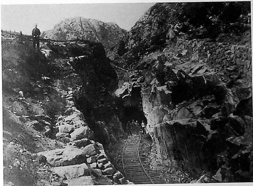
Skjæring og innslag til tunnel på østsiden av Rekveg (Kvam-siden). Foto ulånt av Sven Jonsson.
