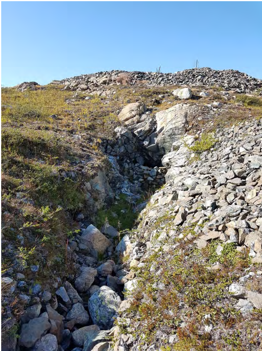
Stoll. Åpningen er murt igjen.
