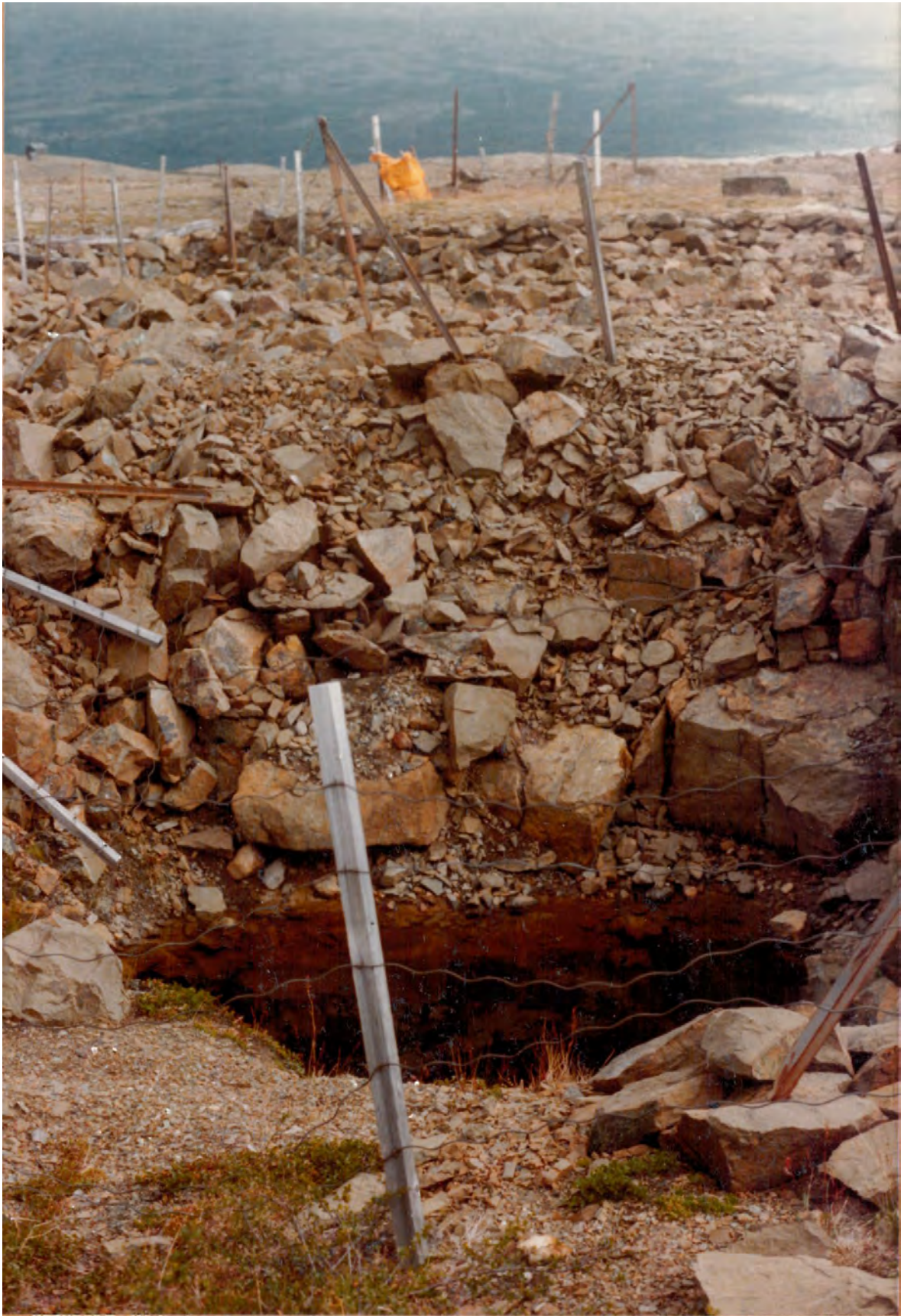
Sjakt rett ved hestevandring wp 236 før sikring i 1979-1982. Foto: Bergmesterens arkiv
