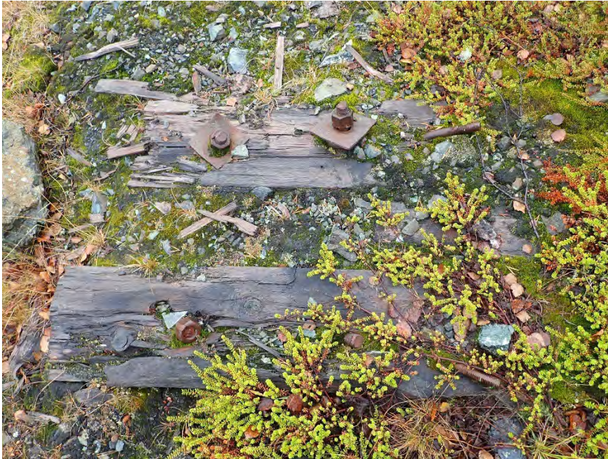
Fundament med gjenstående bolter. Antagelig et fundament for en motor.
