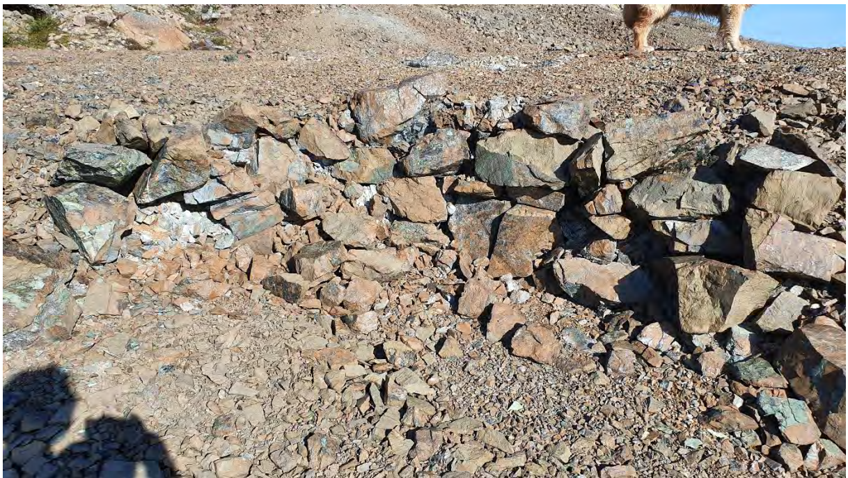
Skisse av muring med bruddstein, sett ovenfra. Under: foto av muring.
