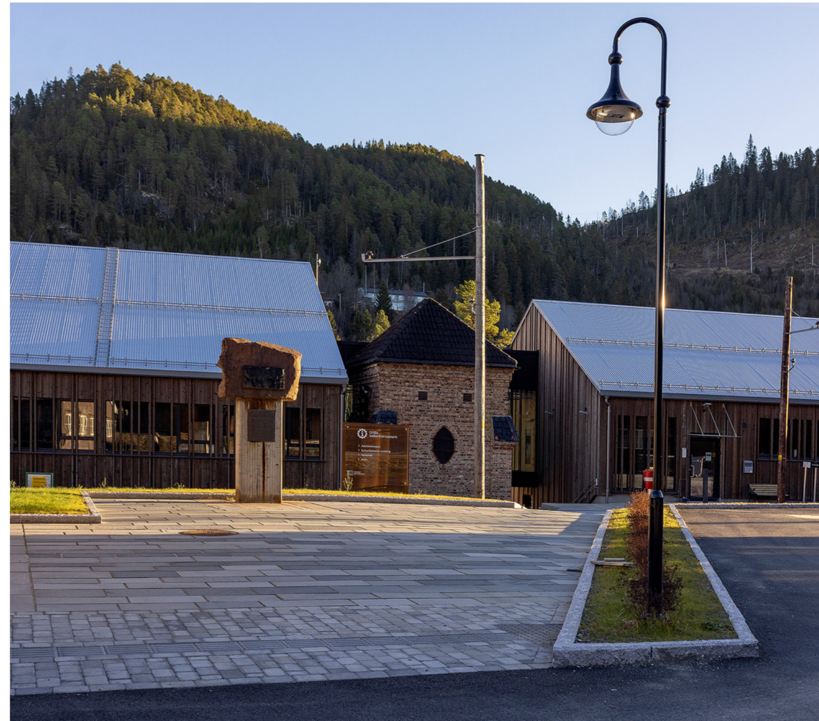
Det nye bygget på Orkla Industrimuseum inneholder jernbaneverksted, magasin og arkiv, kontorer og renoverte utstillingslokaler. Bygget åpnet i juni 2022.
