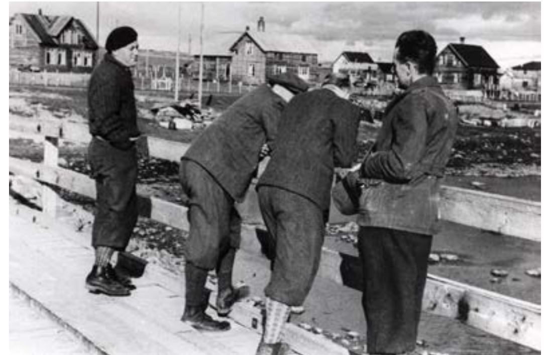
Da krigen kom, fikk Torpp i oppdrag å sprengre bruer. I Finnmark arbeidet Olav Torpp senere med utbedring av krigsskadde bruer. Her på Skallelv provisoriske bru i 1946. Fra venstre Olav Torpp, K.H. Oppegaard, R. Ingebrigtsen og F. Solem.
