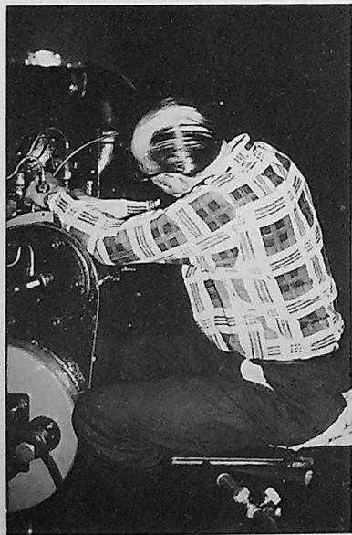
April 1984. Thorleif Pedersen monterer smørerørene på venstre sylinder. Thorleif har laget mange av rørene på Høland, og har bidratt med uvurderlig hjelp på dette området.
