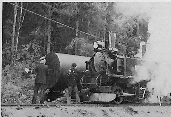
Nr. 8 "BINGSFOS" har gått siste tur i 1978. Personalet renser rør mens kjelen blåses ned. Deretter bar det rett i vognhallen for vinteren.
