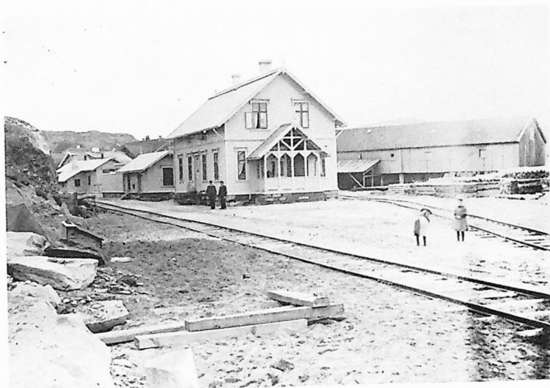
Fra anleggstiden. Stasjonsbygningen i Lillesand. Lokstallen ligger bak stasjonsbygningen til venstre. Bemerk lageret av uimpregnerte gransviller til høyre for stasjonsbygningen.
