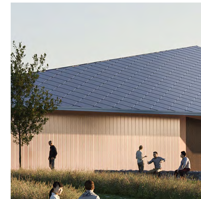
SHINGELTAK I GLASS OG METALLKLEDNING
