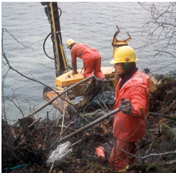
Geita borevogn i arbeid ved sjøkanten etter ras like ved St. Olavs-spranget på riksvei 715, mellom Trondheim og Flakk i april 1982. (Foto: Ingvær Tøndel)
