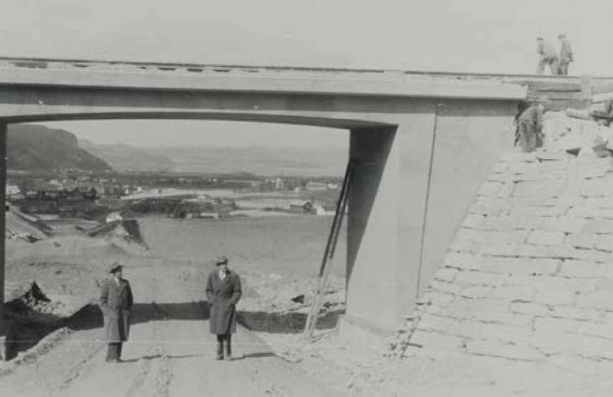
Befaring på veganlegget Selsbakk-Klett. Bildet er tatt ca. 1960 og viser jernbaneundergangen ved Storli. Fra venstre vegdirektør Backer og vegsjefen i Sør-Trøndelag, Arne Tronstad.
