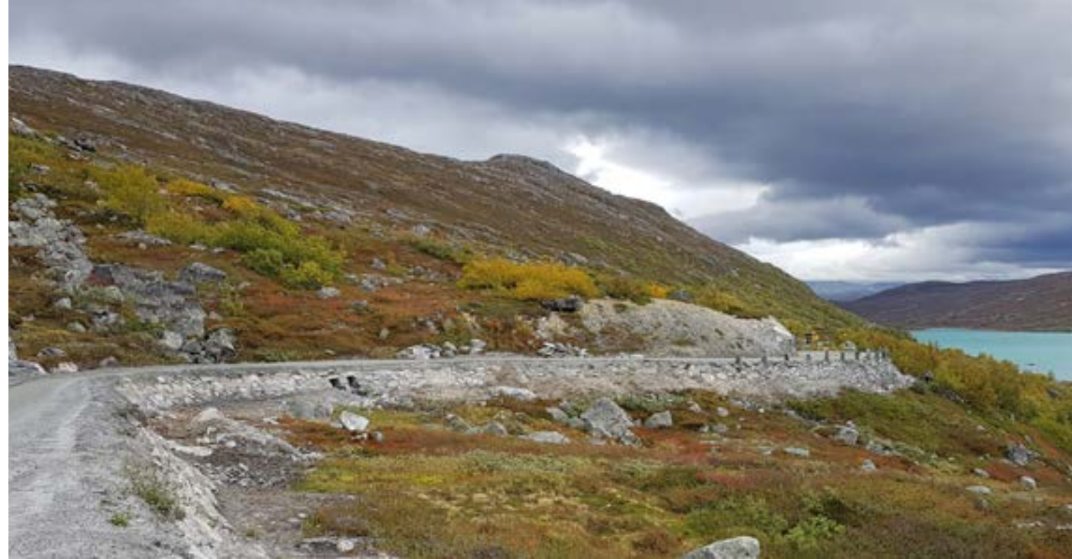
Gamle Strynefjellsvegen med grusdekke, kistestikkrenner og stabbesteinsrekkverk ved Heilstuguvatnet i 2019. (Foto: Ann Kristin Engh)
