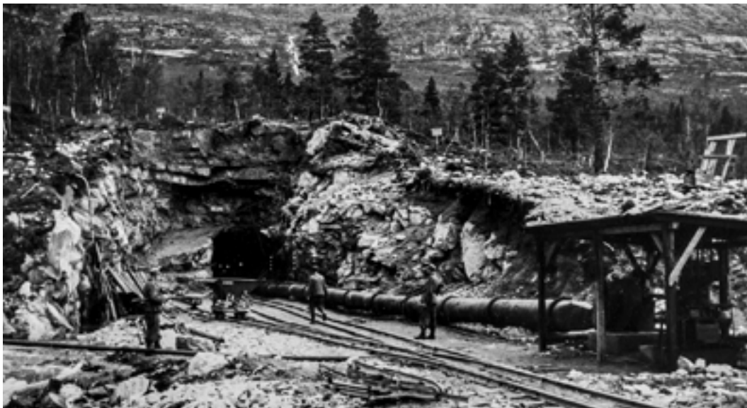
Forskjæring og innslag for Basis tunnel. Søndre portal ble lagt i Gjerdalen. (Foto Lothar Pieper, OT arkiv Riksarkivet).
