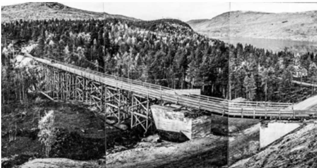
Viadukten ved Falkelv og brua over vegen i 1944. "Betongklossen" er vestre brufeste for en jernbanebru som skulle bygges der det i 1944 var midlertidige anleggsbruer. (Foto Lothar Pieper/OT arkiv Riksarkivet)
