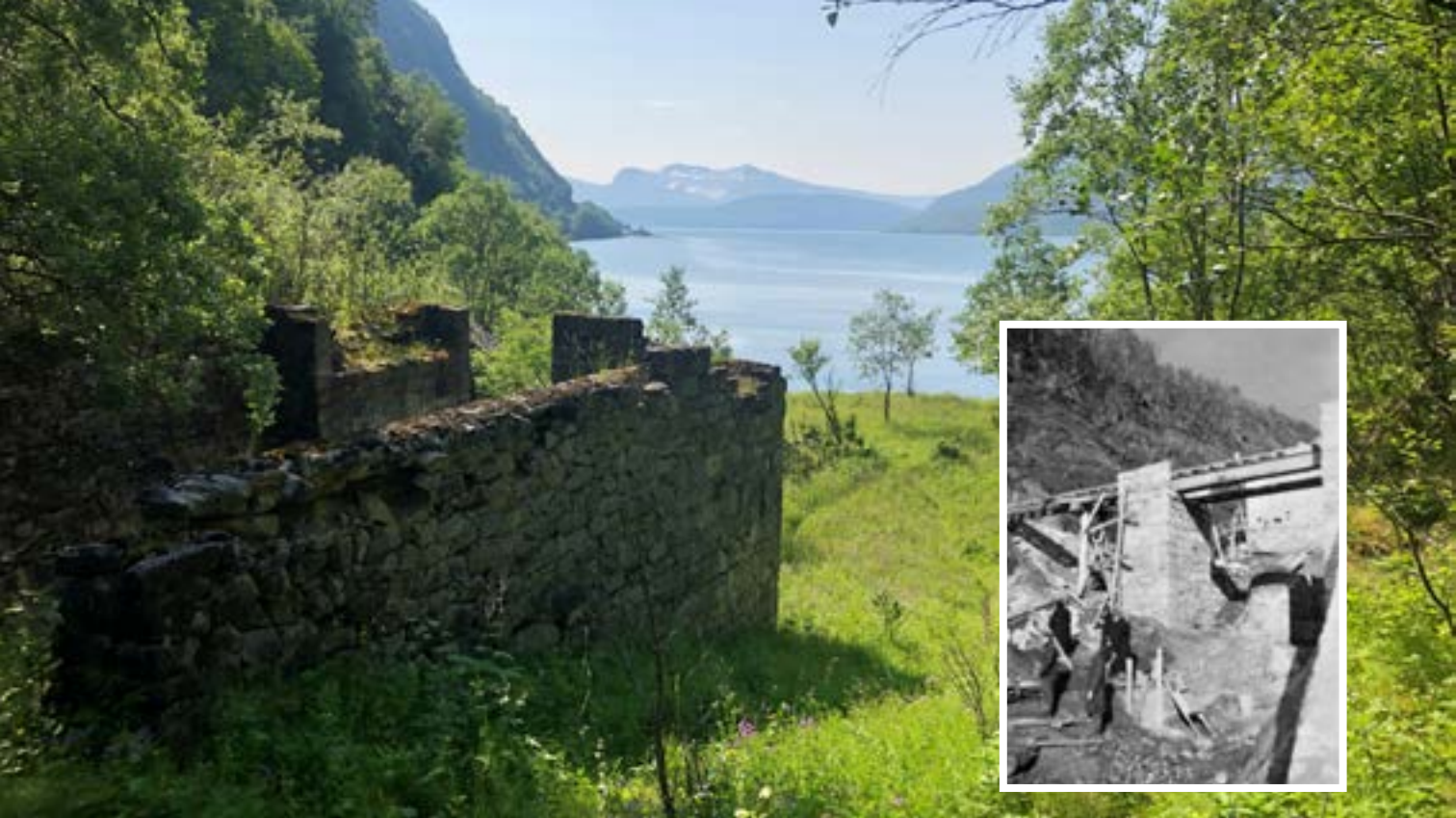
Ved Gyltvik stor store steinmurer og minner om det gigantiske jernbaneprojektet. Stedet ligger kort vei ned fra E6 men det er ikke skiltet til krigsminnedet. (Foto: Håkon Aurlien, Innfelt bilde fra Todt-arkivet)
