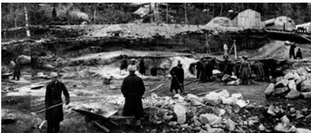
Sovjetiske krigsfanger arbeider under tvang på tomten til Rekvatnet kraftstasjon ved Kråkmo.
