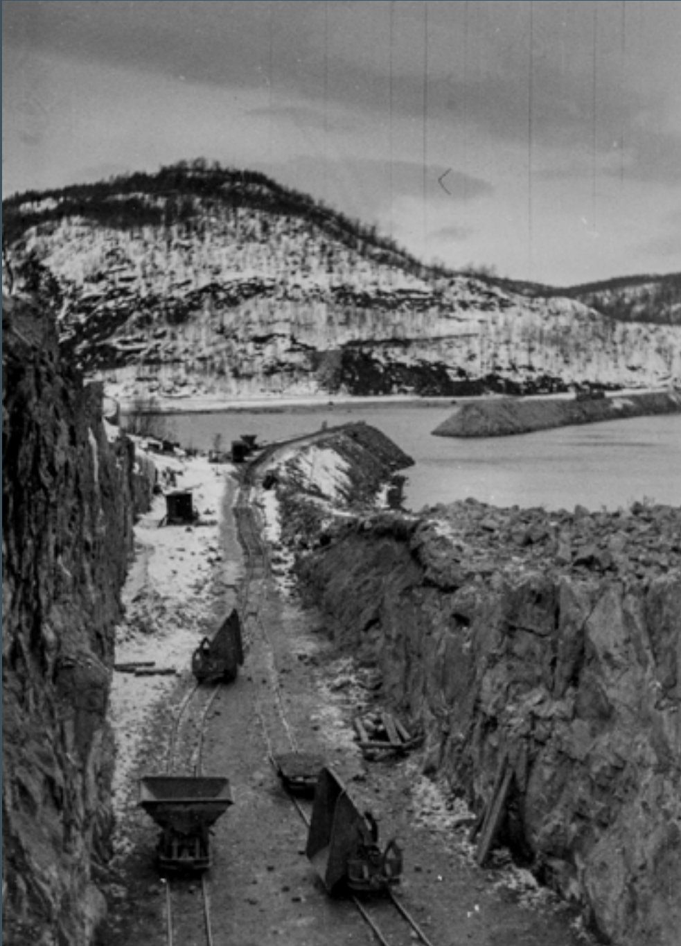
Fotograf Lothar Pieper tok dette bildet fra byggingen av "Die Polareisenbahn" ved Straumen i Sørfold i 1944. I 60-årene ble dagens E6 lagt gjennom denne fjellskjæringen og over steinfyllinga, som altså var bygd av russiske krigsfanger med tap av mange menneskeliv. (Foto fra OT-arkivet ved Riksarkivet i Oslo)
