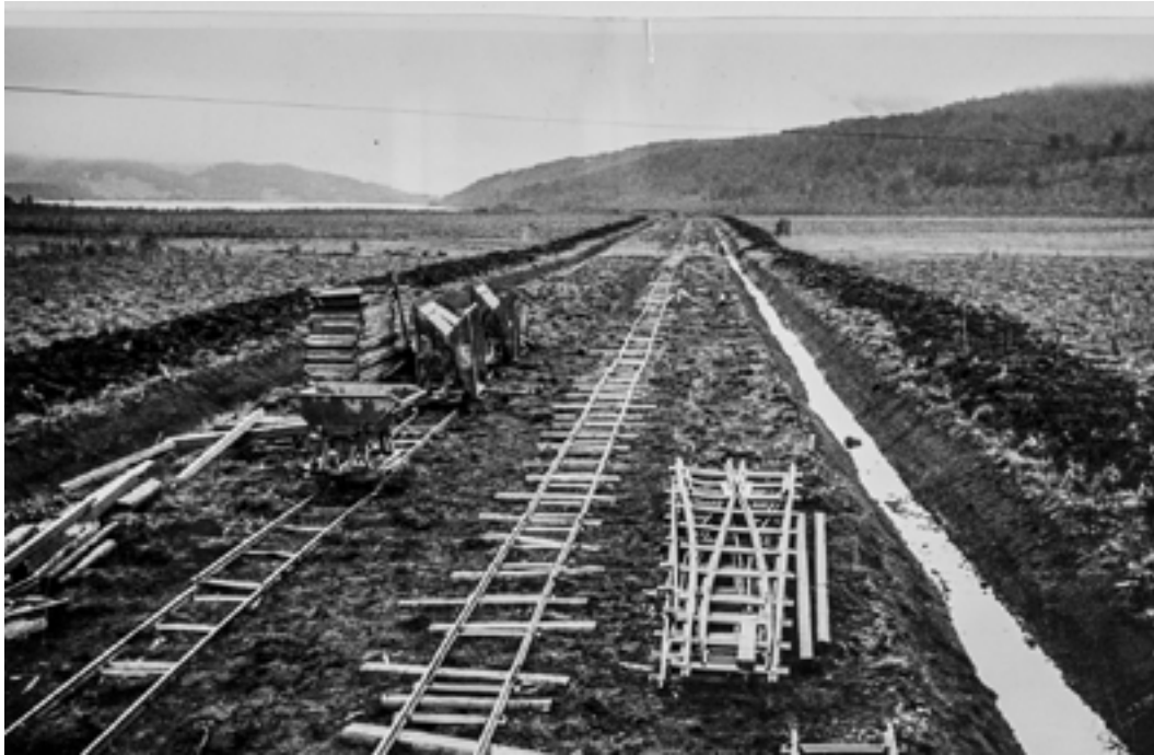
Over Fauskemyrene måtte det graves dype dreneringsgrøfter for å tørke ut grunnen slik at den kunne bære jernbanen. Traseen er på store deler av strekningen synlig den dag i dag. (Foto fra OT-arkivet)
