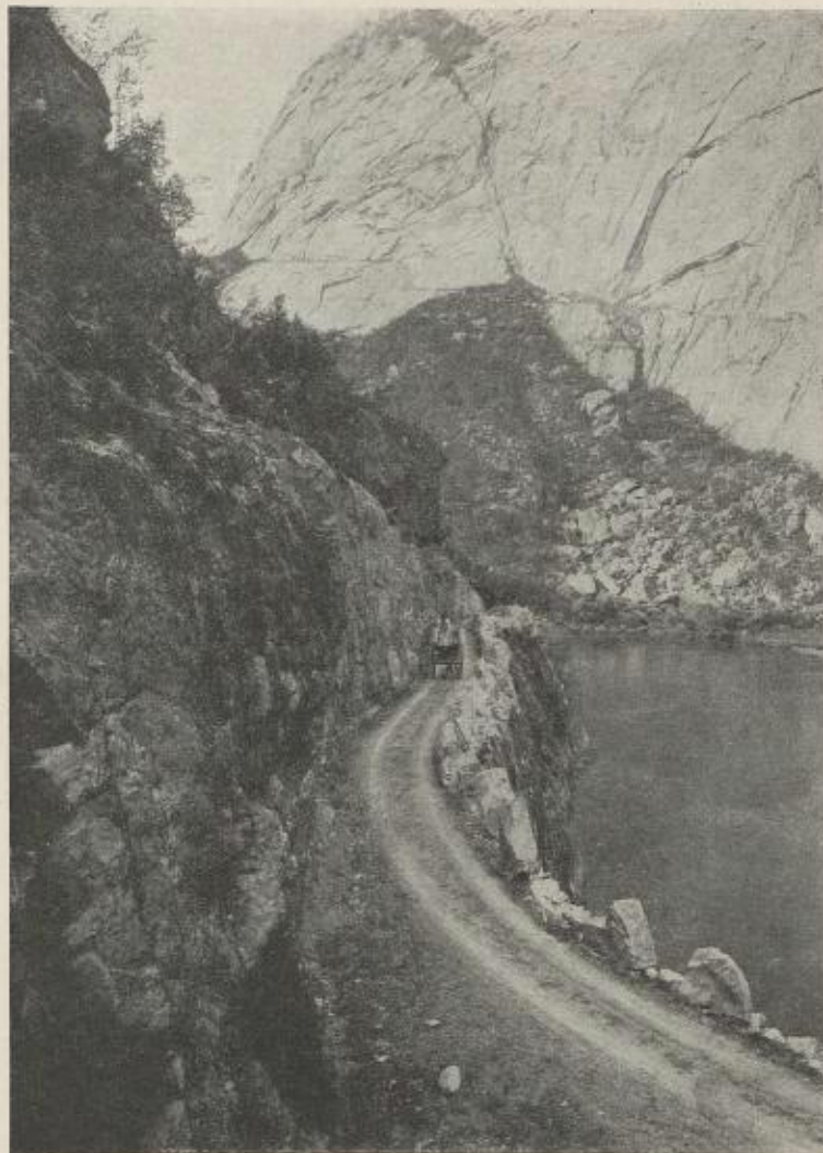
51. Ved Byklestigen efter omlegningen av veien
