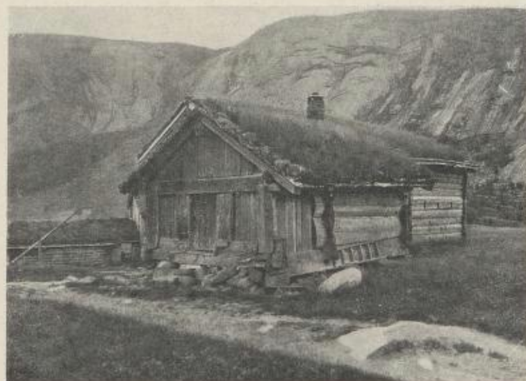
141. Stolpehus, Kjelleberg, Valle
