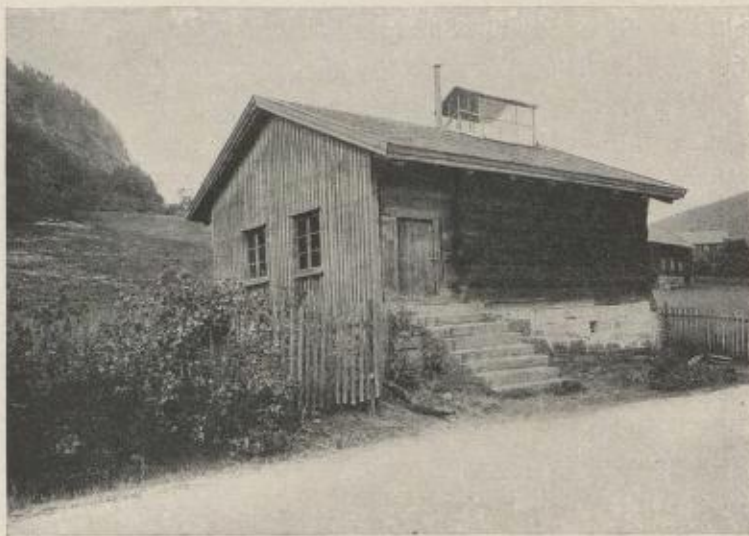
53. Kommunelokalet i Bygland
